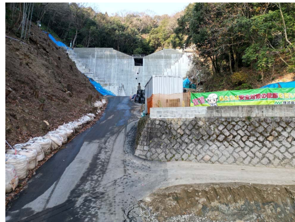
【施工箇所（下流側より）】
