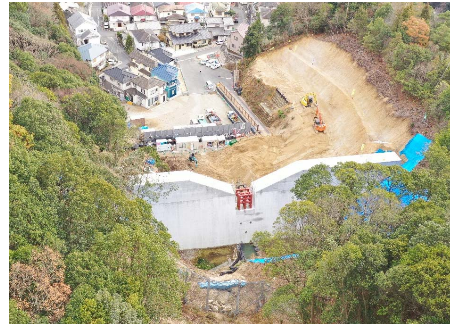
【施工状況（上流側より）】
