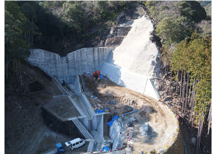
【580支川溪流 施工状況】
