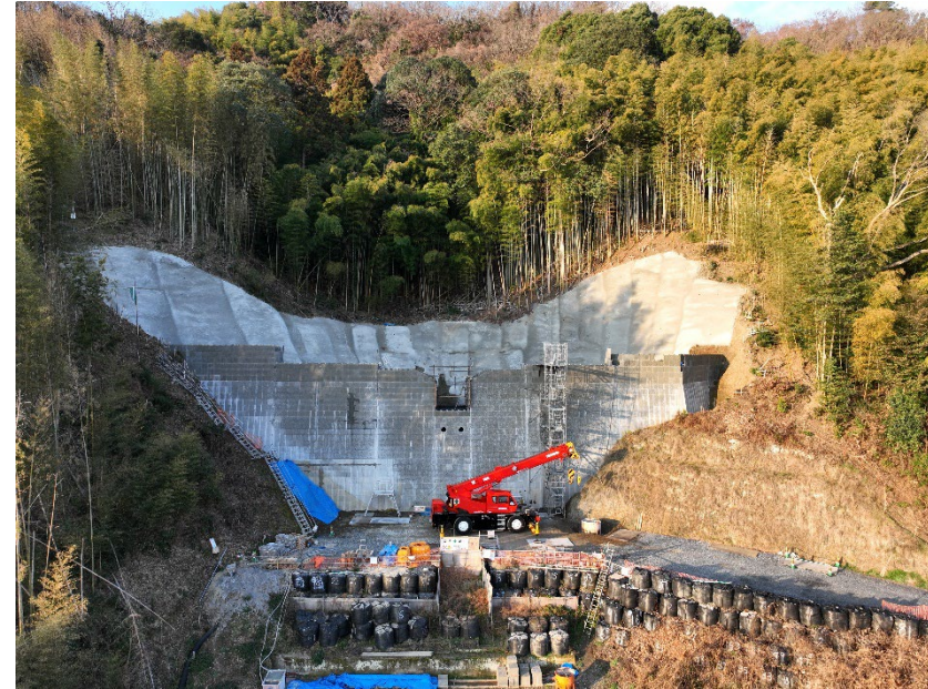
【施工状況（下流側より）】
