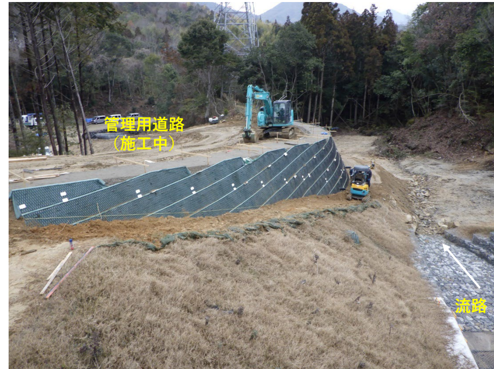
【施工状況 (管理用道路)】
