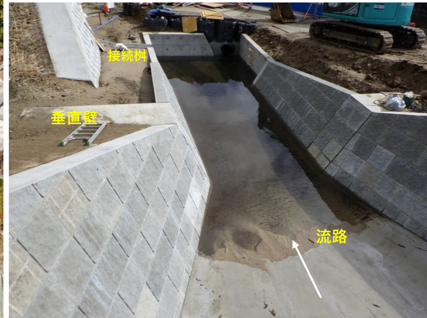
【施工状況：流路】
