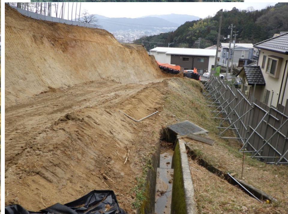
【施工状況（管理用道路：掘削状況）】
