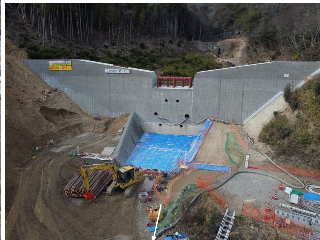
【前庭保護（側壁・水叩き）の施工状況】
