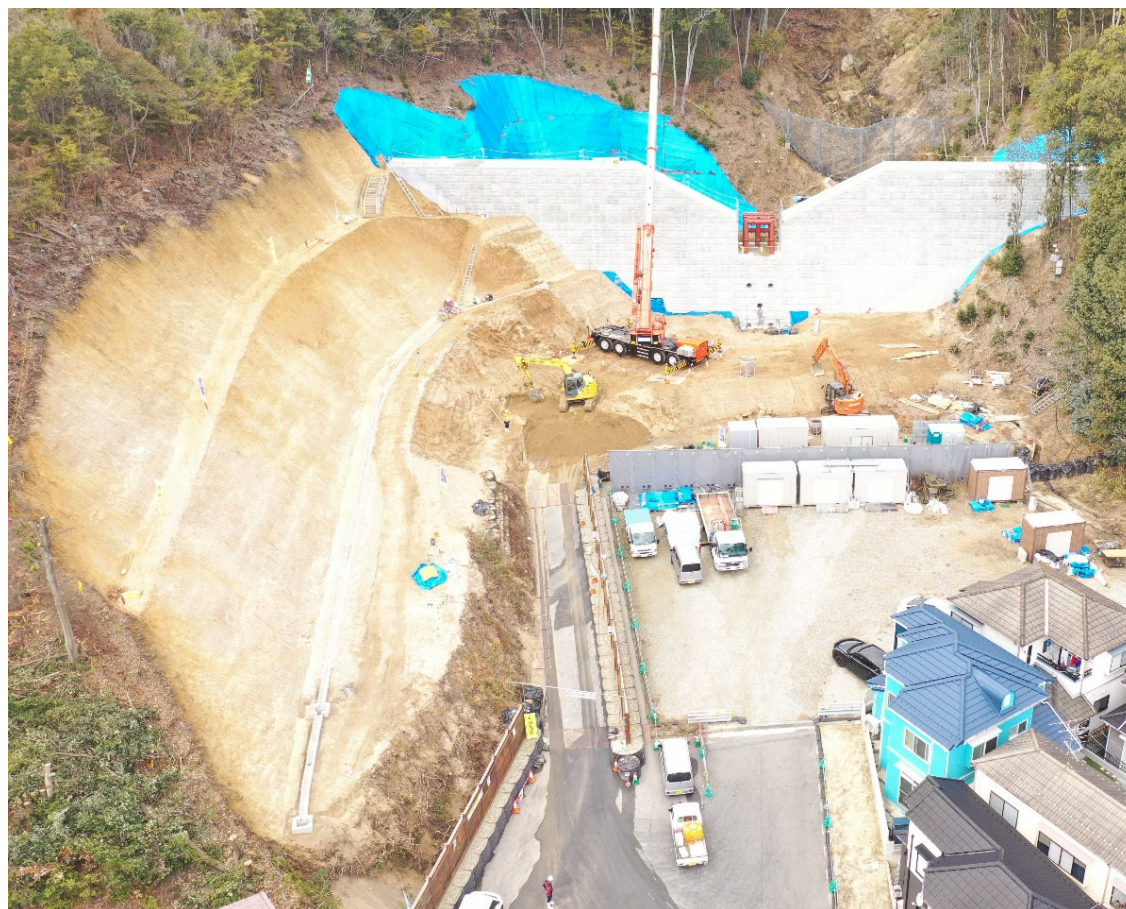
【施工状況（下流側より）】
