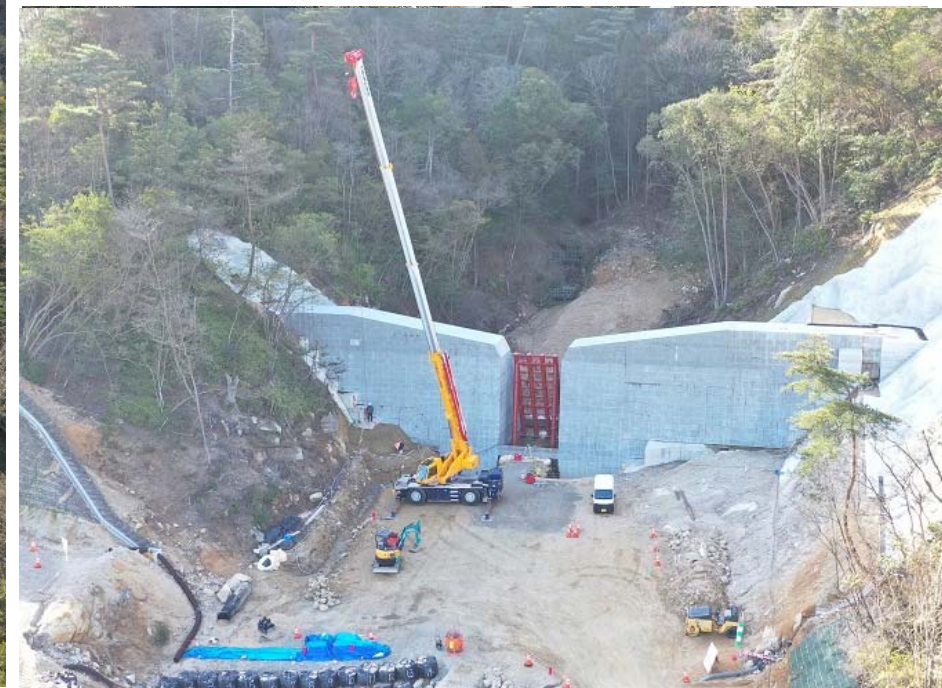
【大谷川2号砂防堰堤・鋼製スリット施工状況】
