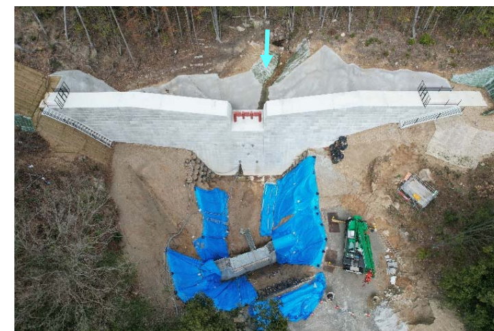
【前庭保護工の施工状況】
