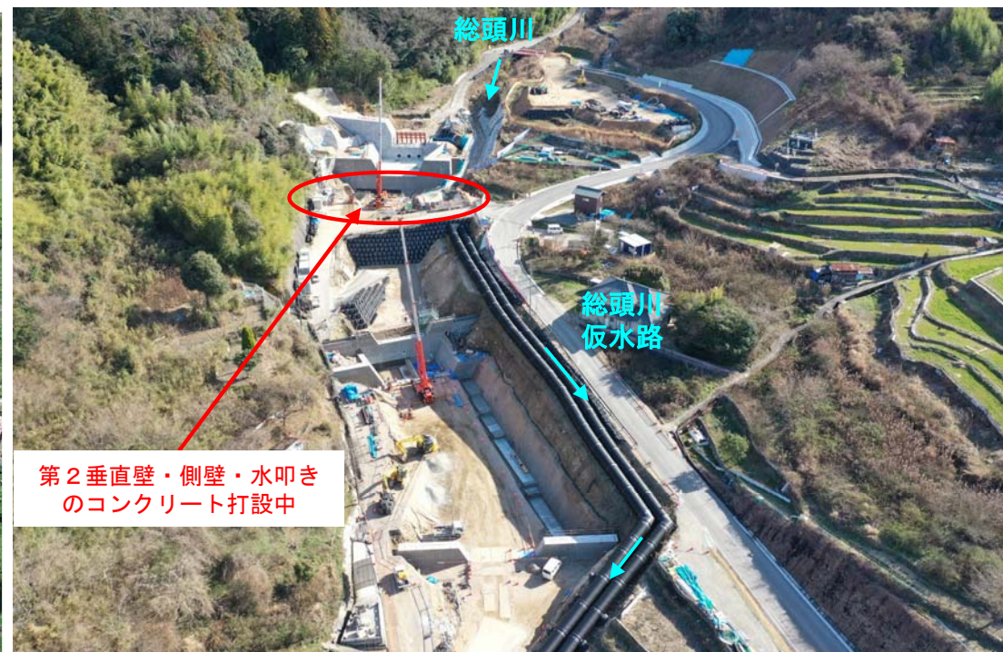
【施工状況(下流から上流を望む) (R6. 2月末時点)】
