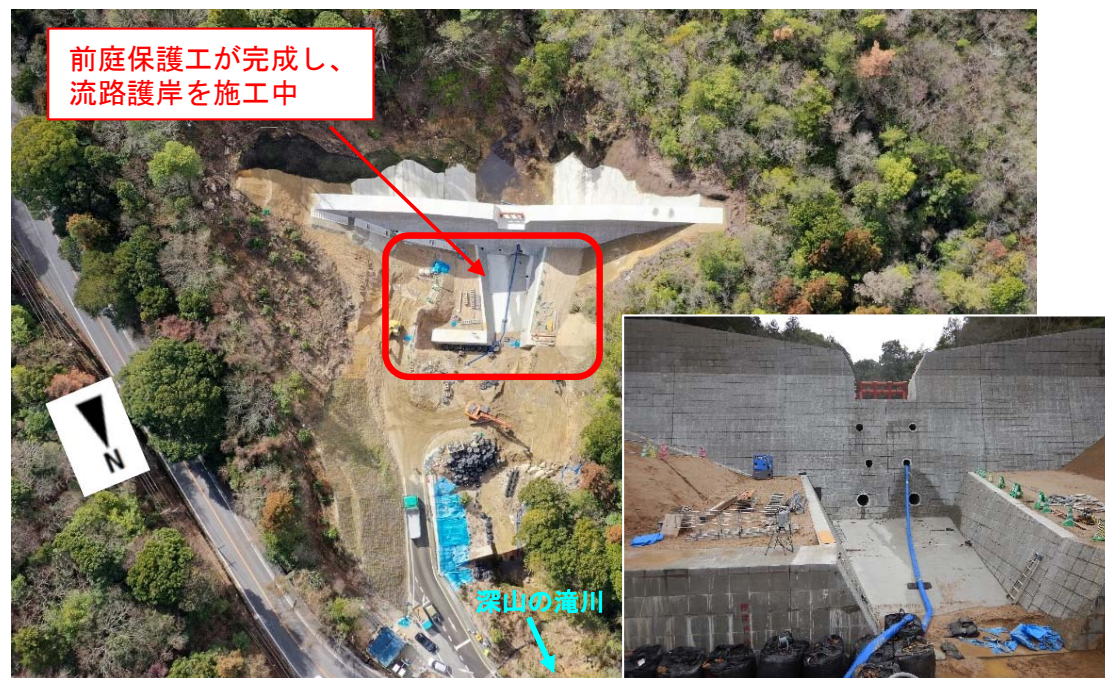
【深山の滝川 1号砂防堰堤の施工状況】
