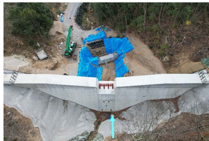
【前庭保護工の施工状況】
