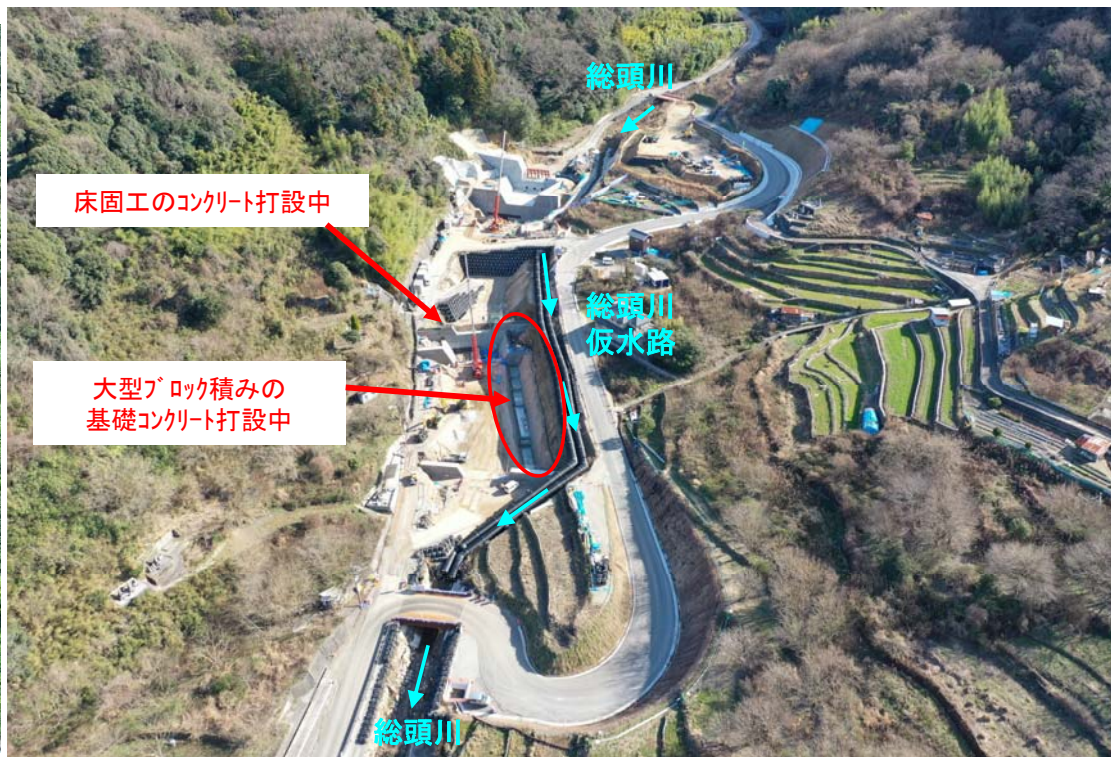
【施工状況（下流から上流を望む）（R6. 2月末時点）】
