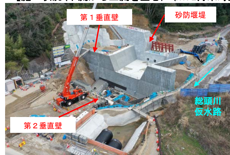
【第2垂直壁・側壁・水叩きのコンクリート打設削状況（下流から上流を望む）】
