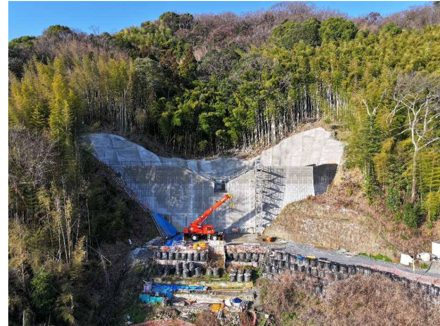
【施工状況（下流側より）】
