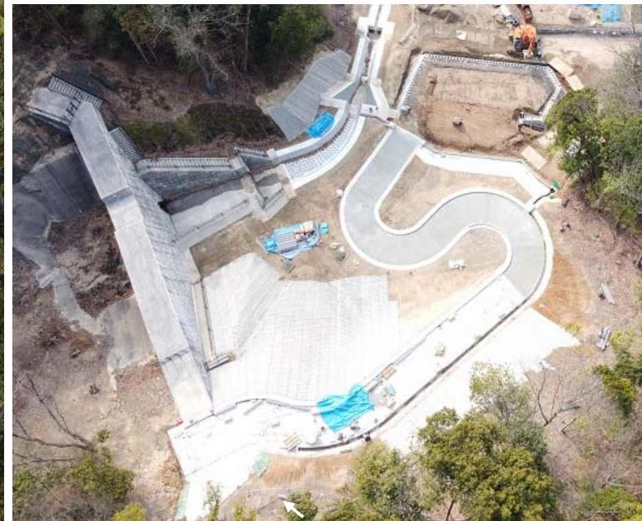
【管理用道路 施工状況】
