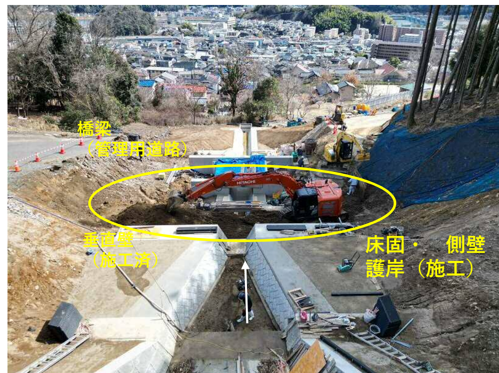
【流路（床固・側壁護岸）の施工状況】
