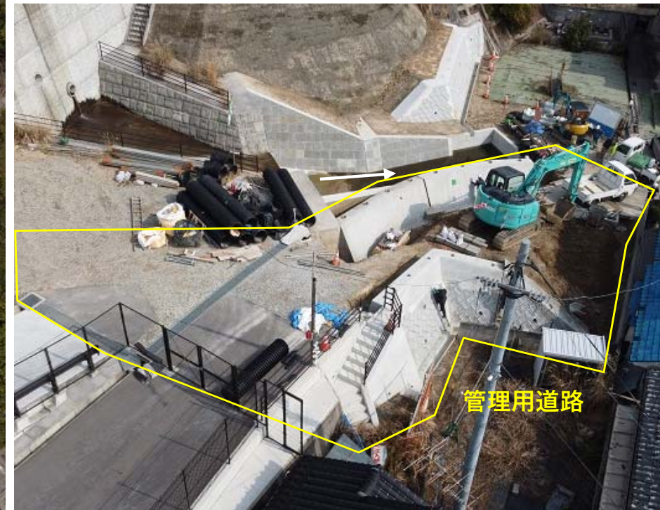
【施工状況：流路】
