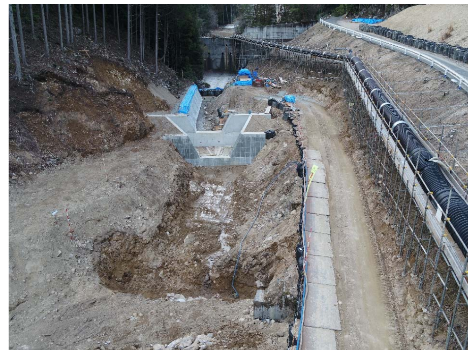
【580溪流 流路工施工状況】
