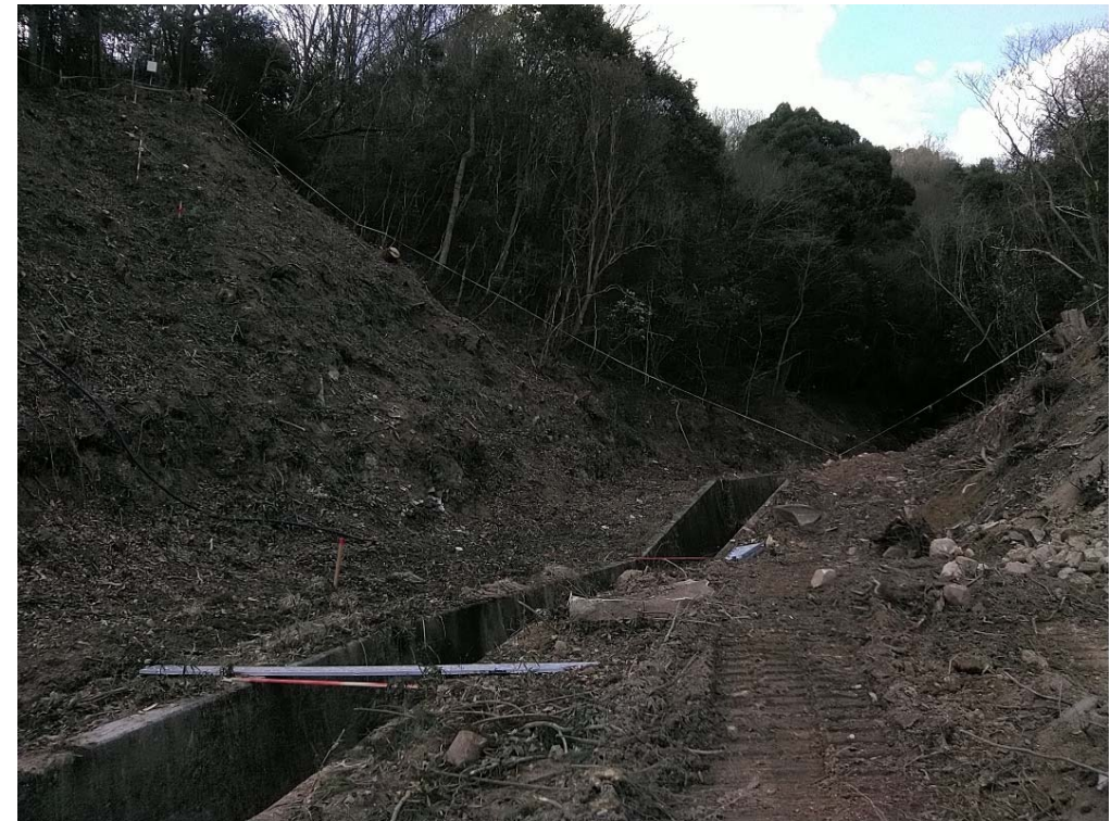
【施工状況（下流側より）】
