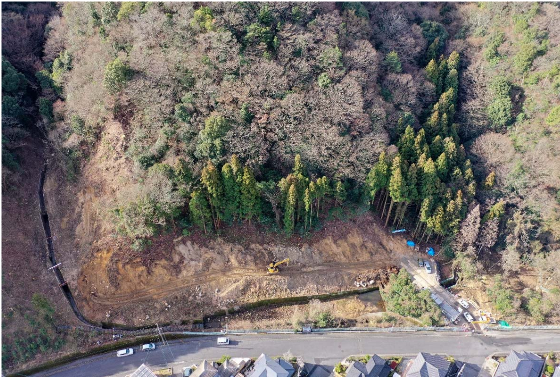
【施工状況（上空より）】
