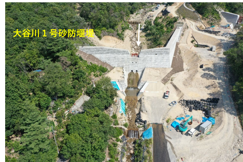
【大谷川1号砂防堰堤】
