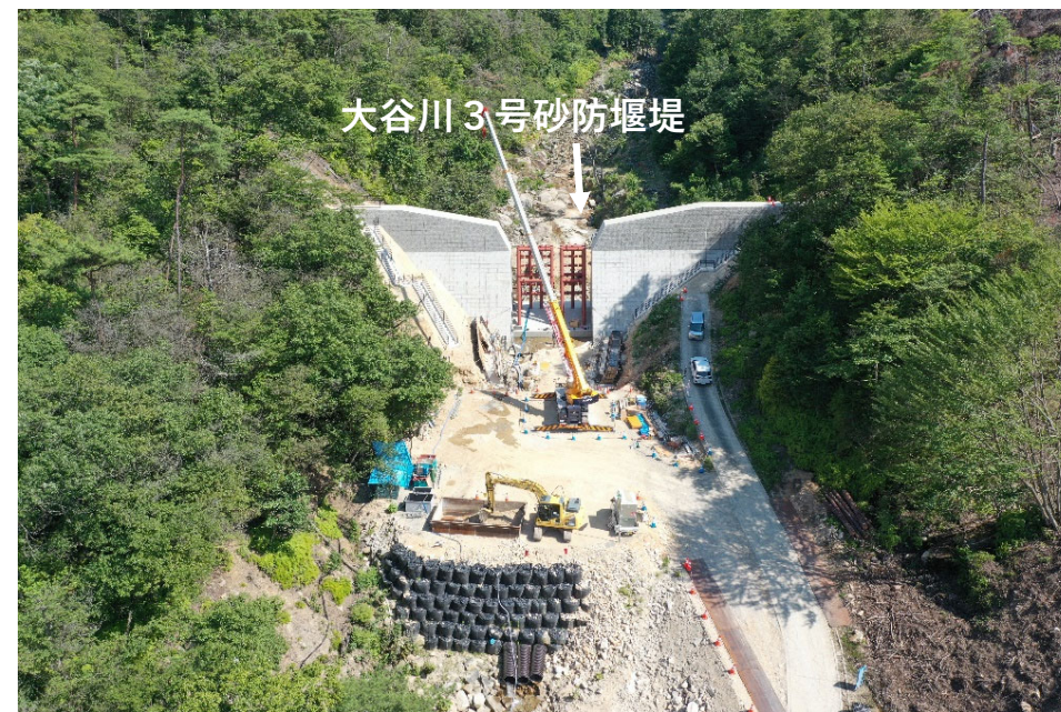
【大谷川 3 号砂防堰堤】
