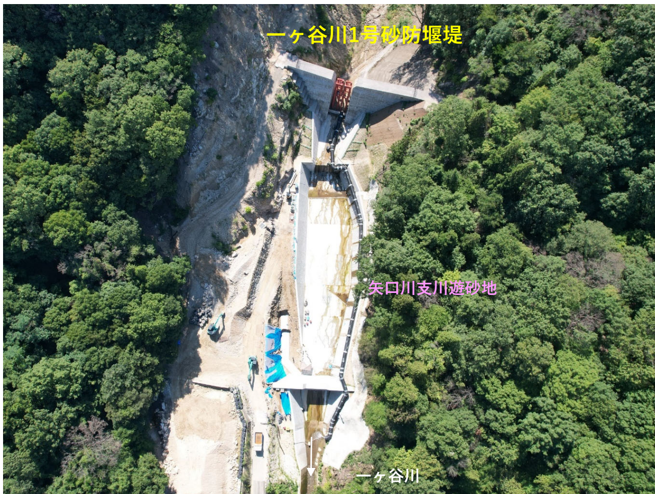
【矢口川支川遊砂地 全景】
