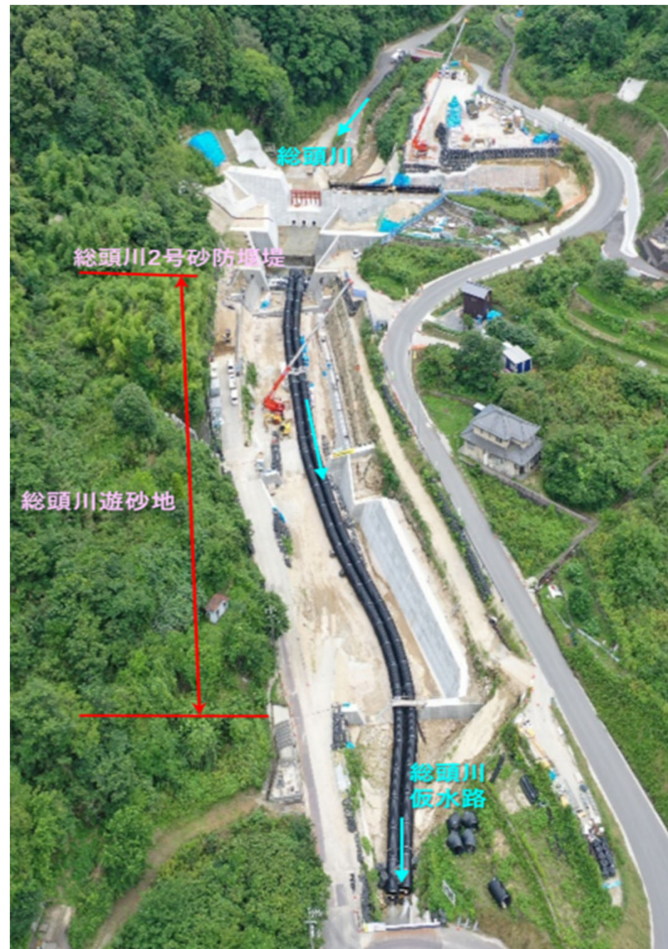
【施工状況(下流から上流を望む)】
