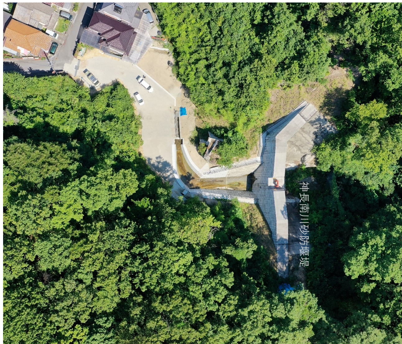
砂防堰堤全景 (令和6年7月末現在)
