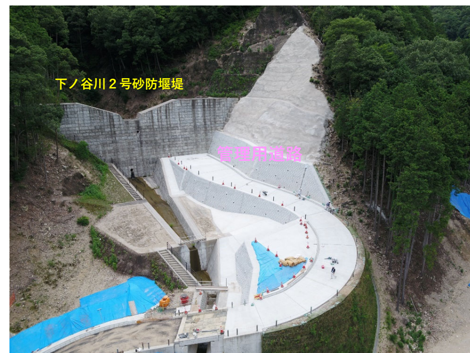
【管理用道路施工状況】
