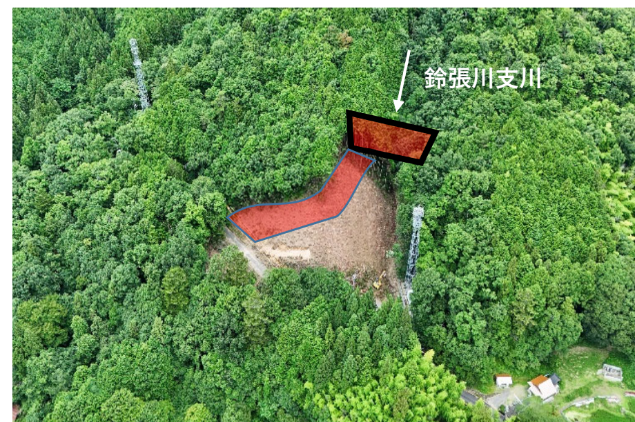
【伐採作業 施工状況】
