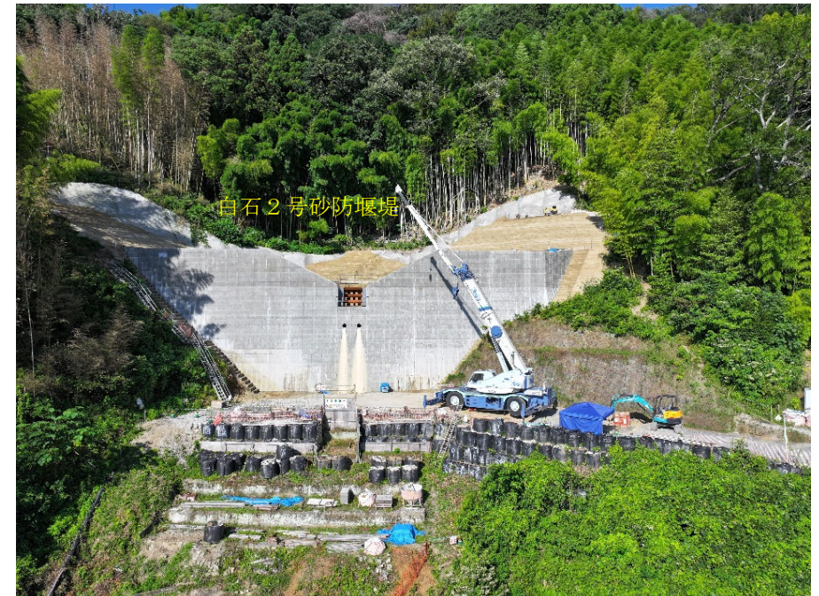
【施工状況（下流側より）】
