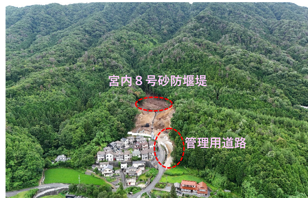
【施工状況（下流側より）】
