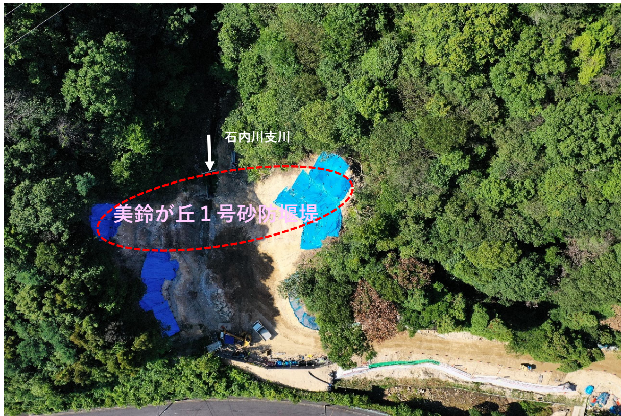
【施工状況（上空より）】
