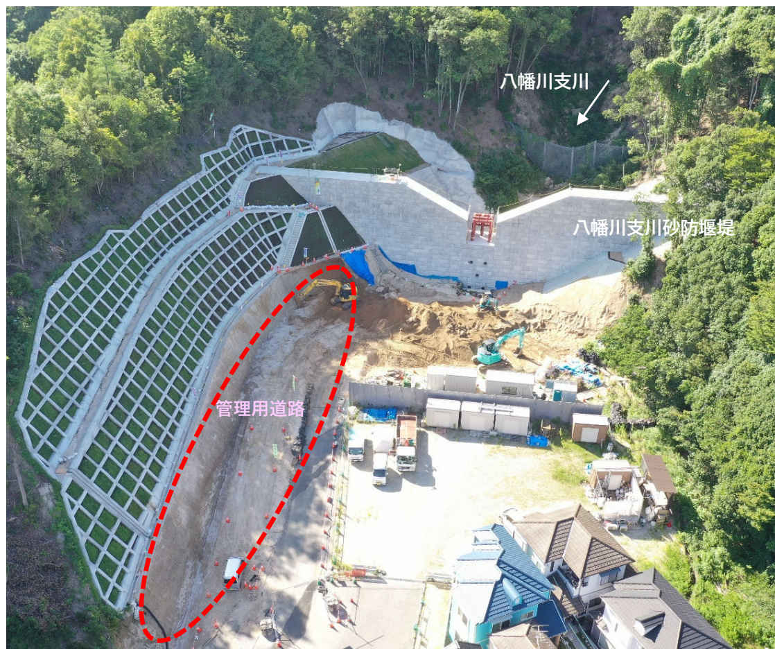
【施工状況（下流側より）】
