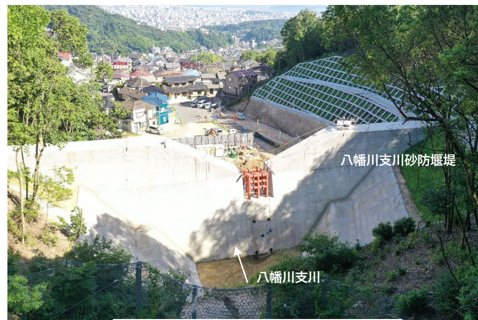
【施工状況（上流側より）】
