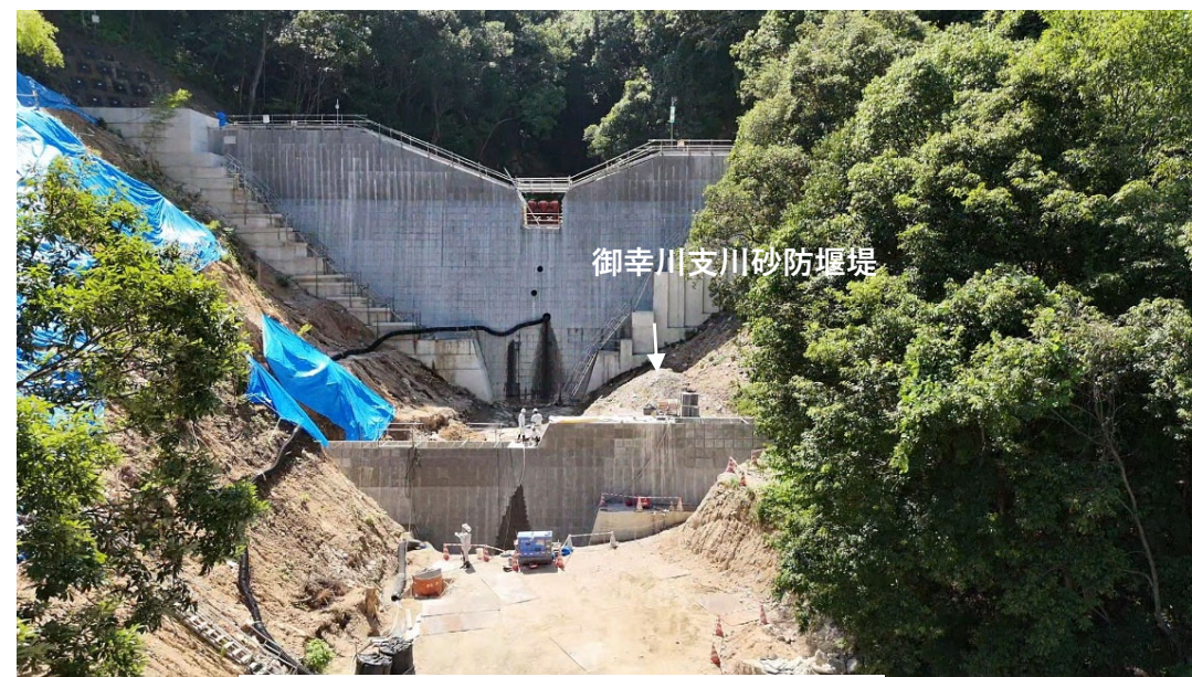
【施工箇所（下流側より）】
