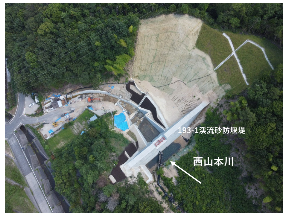
【堰堤上空からの施工状況】
