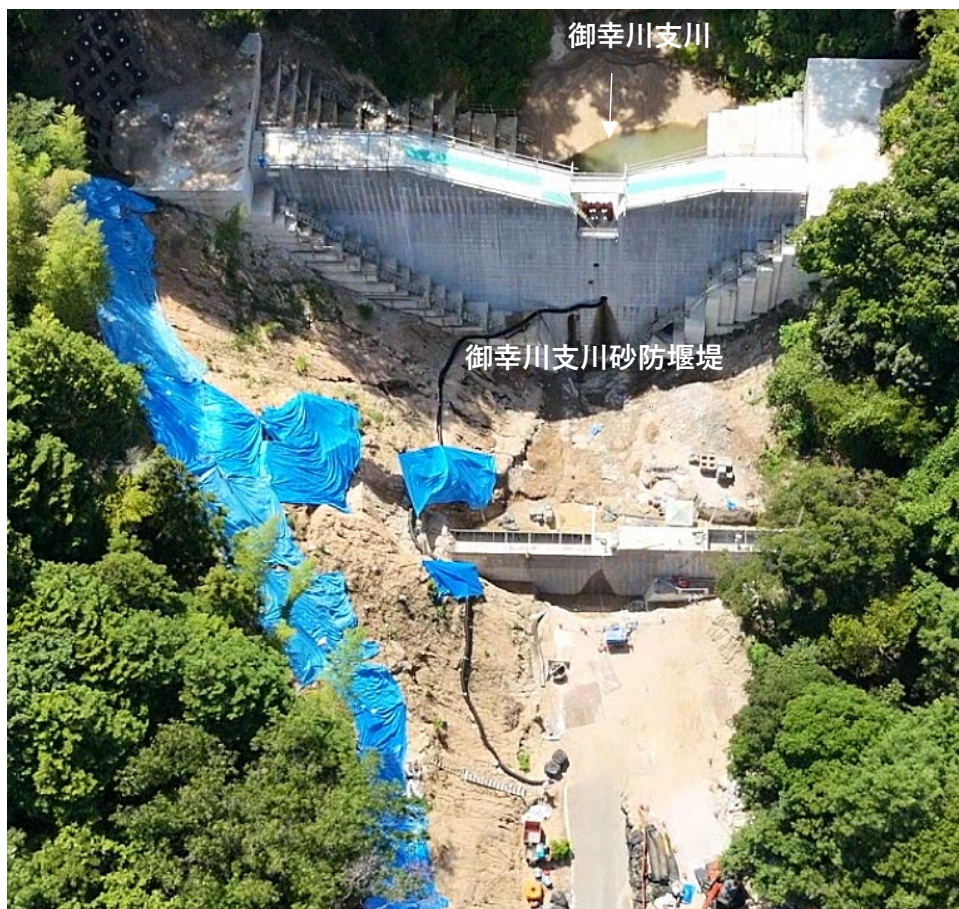
【施工状況（上空より）】
