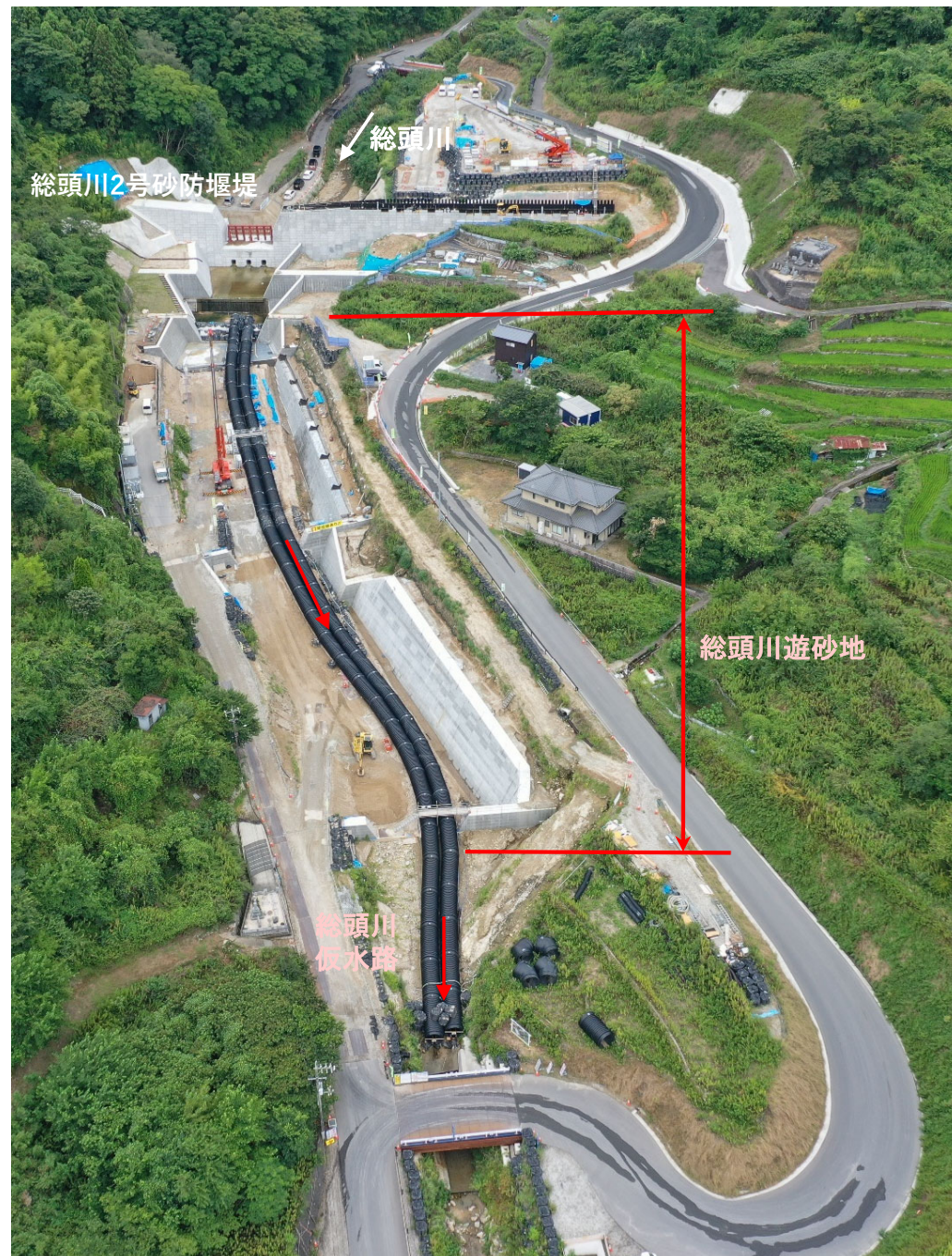
【施工状況(下流から上流を望む)】
