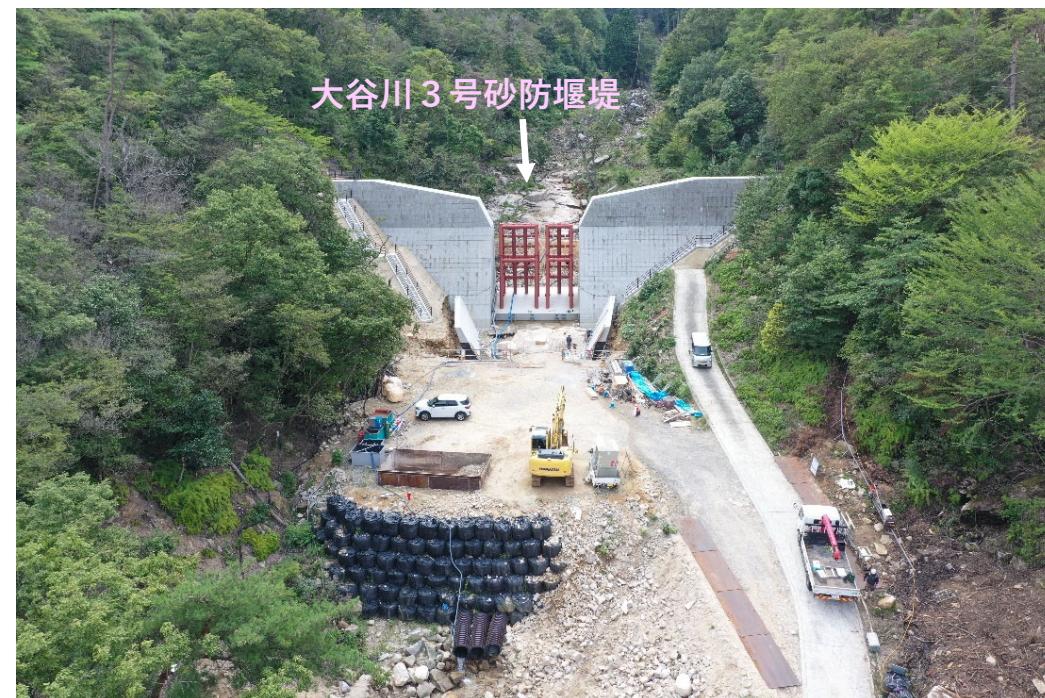
【大谷川 3 号砂防堰堤】
