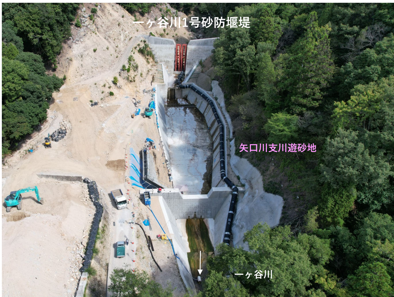
【矢口川支川遊砂地 全景】
