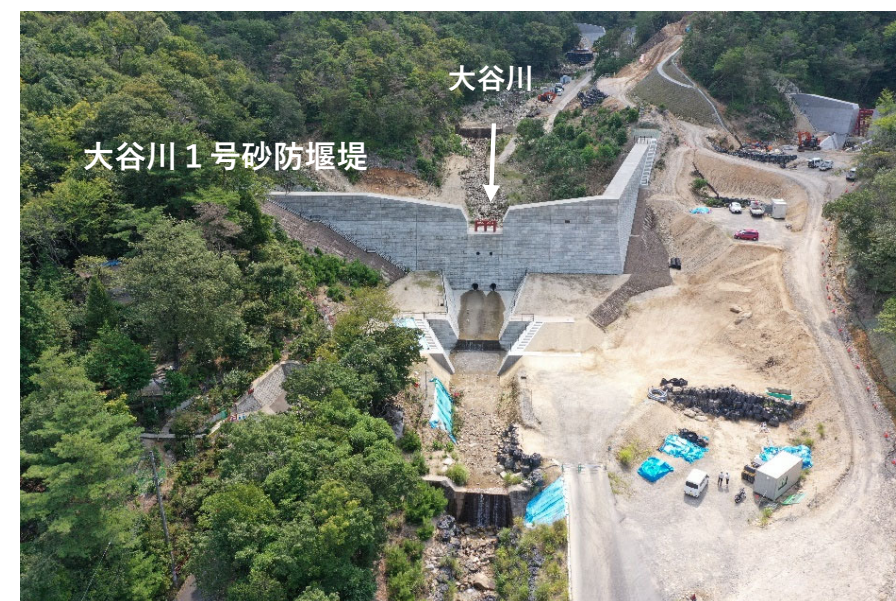
【大谷川 1 号砂防堰堤】
