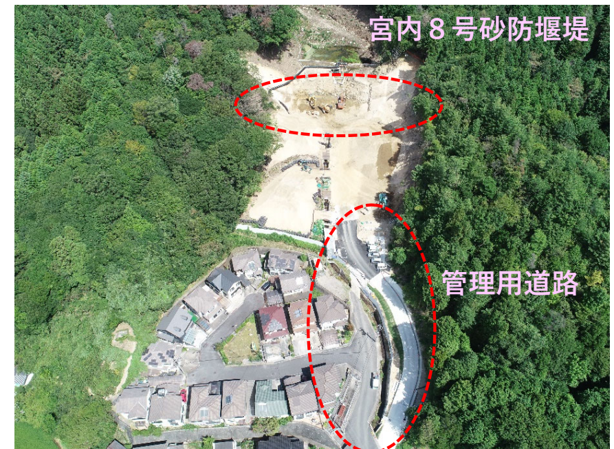
【施工状況（下流側より）】
