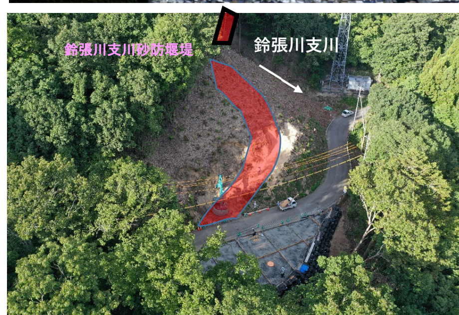
【掘削作業 施工状況】
