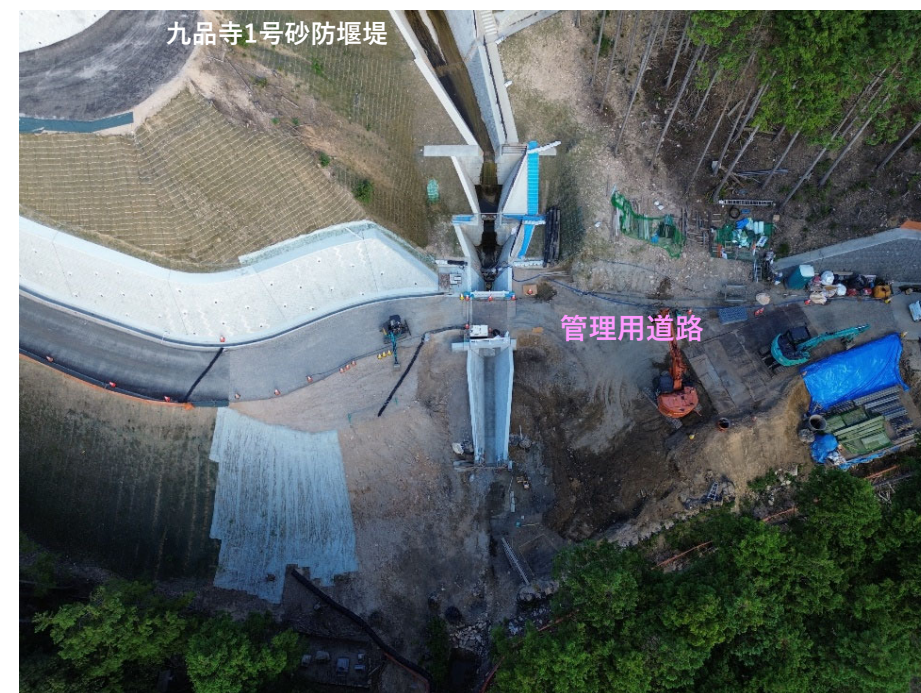
【九品寺 1 号砂防堰堤溪流保全工箇所 施工状況】
