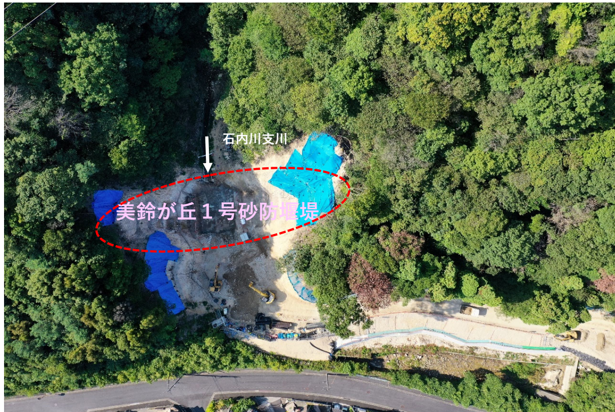
【施工状況（上空より）】
