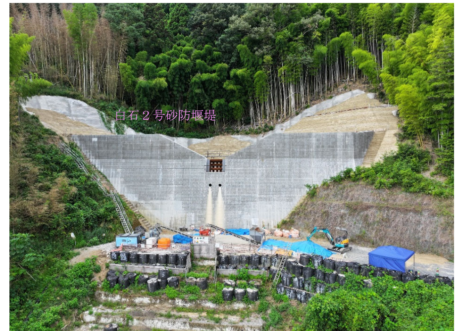
【施工状況（下流側より）】
