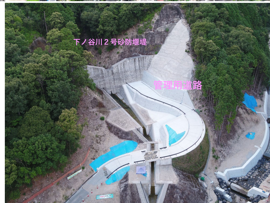
【管理用道路施工状況】
