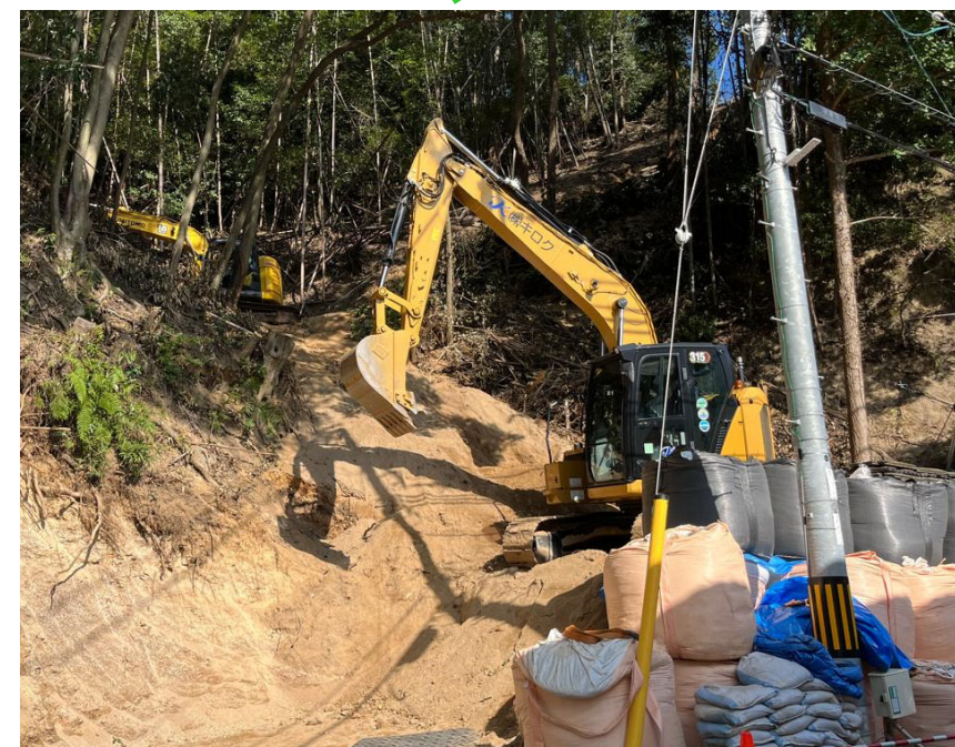
【管理用道路 施工状況】
