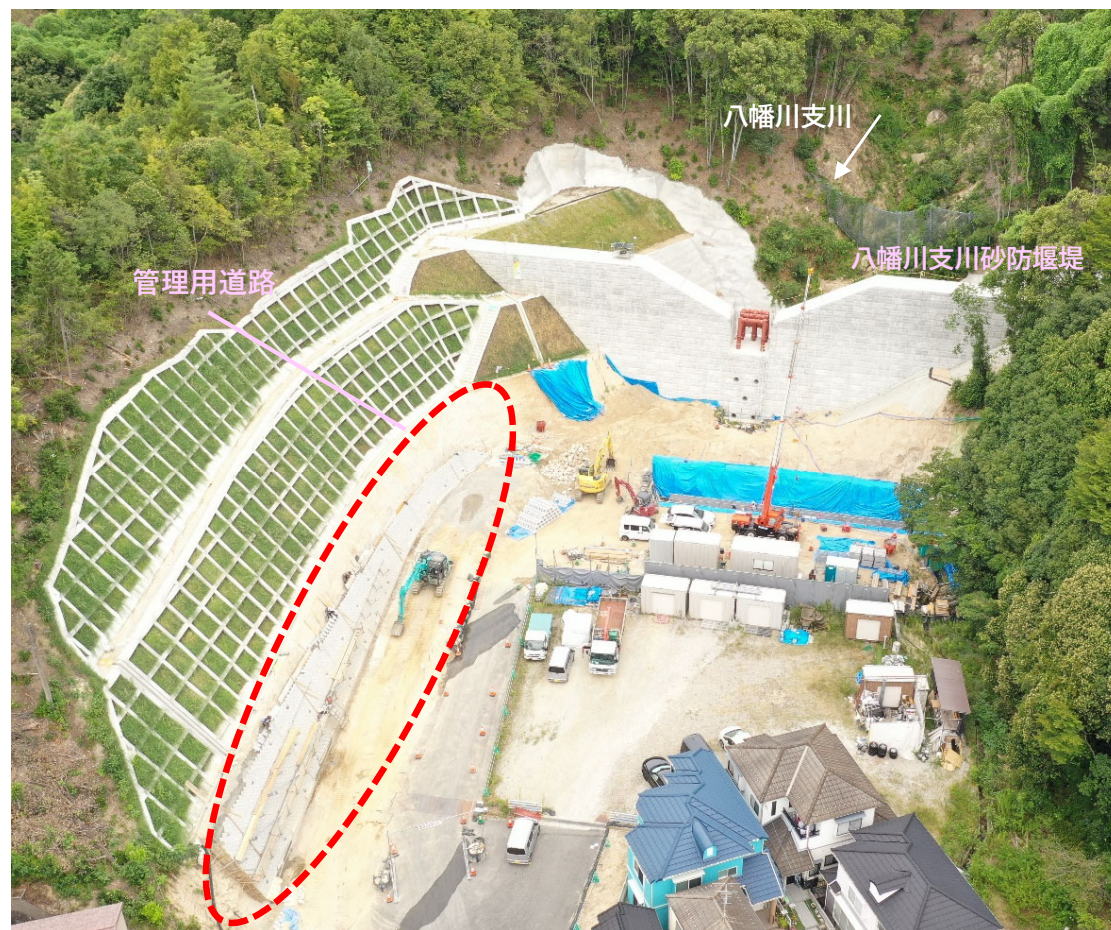
【施工状況（下流側より）】
