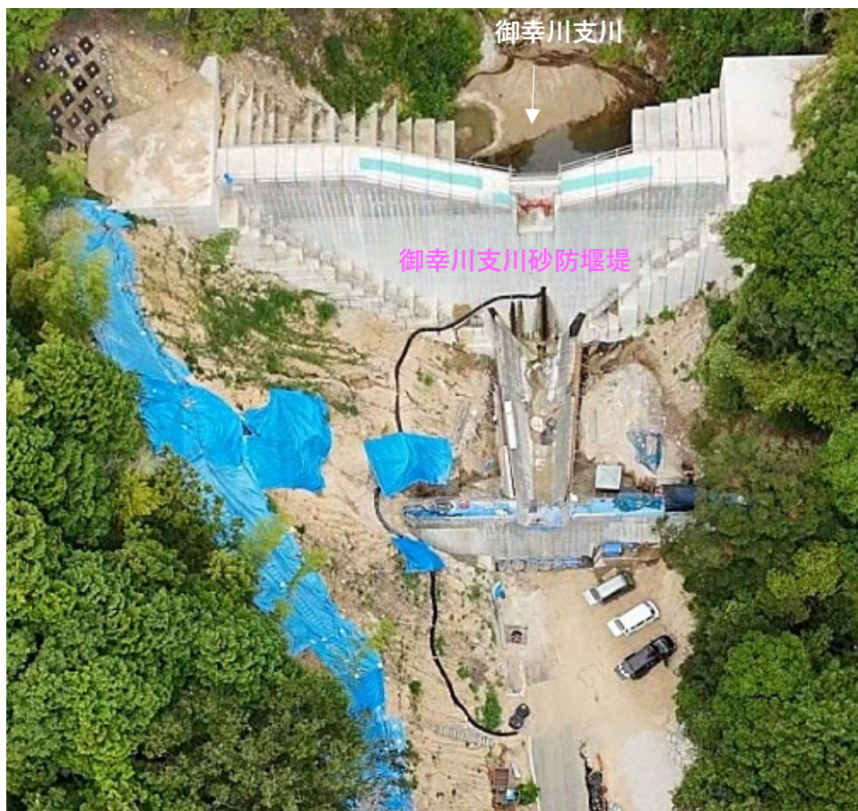
【施工状況（上空より）】
