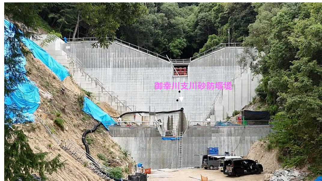
【施工箇所（下流側より）】
