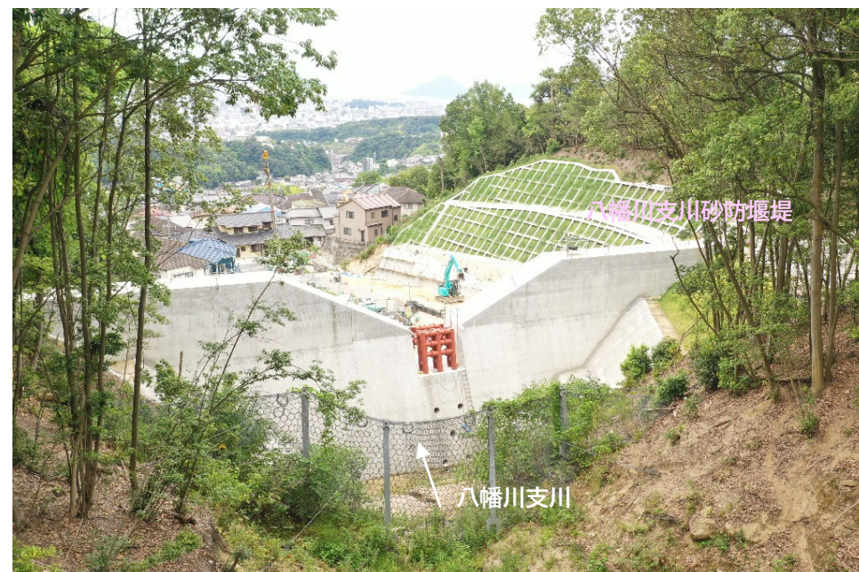
【施工状況（上流側より）】
