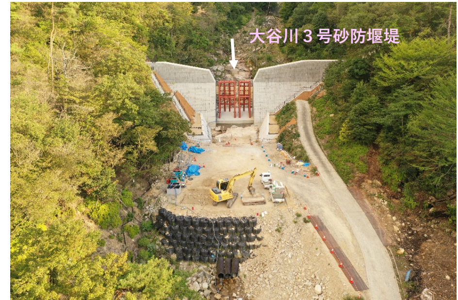
【大谷川 3 号砂防堰堤】
