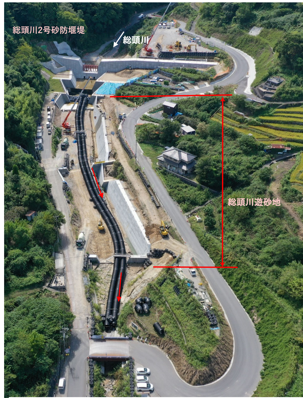
【施工状況(下流から上流を望む)】
