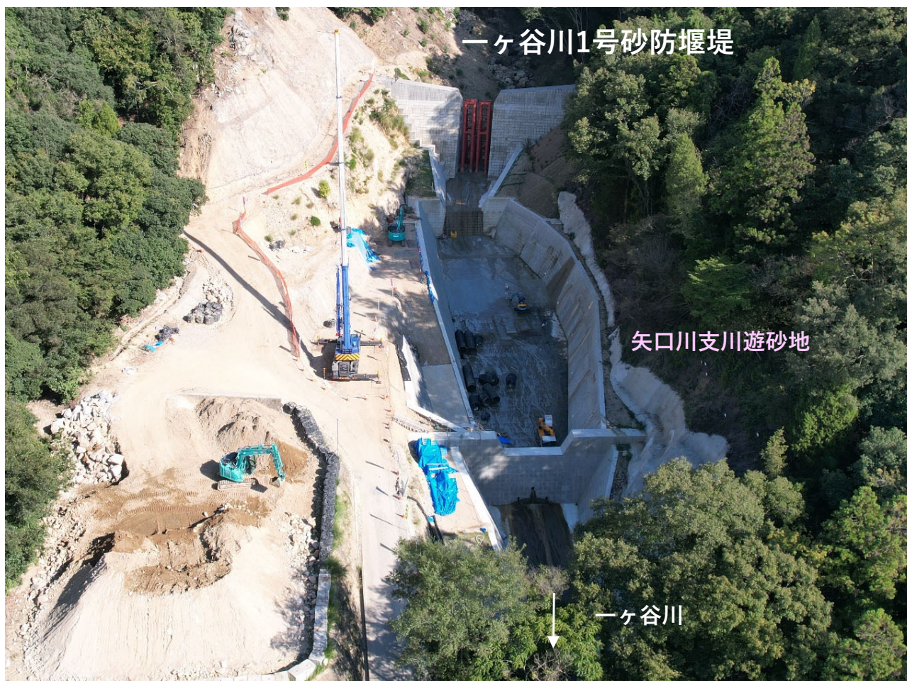
【矢口川支川遊砂地 全景】
