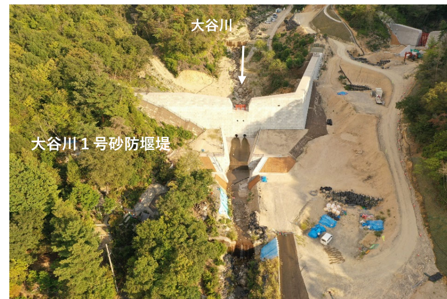
【大谷川 1 号砂防堰堤】
