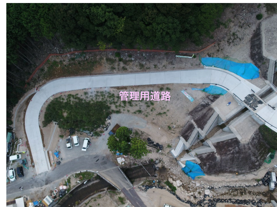
【管理用道路施工状況】
