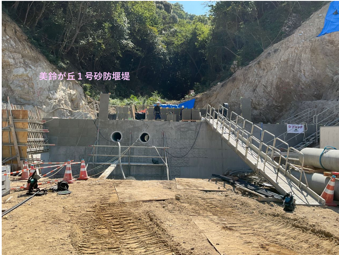
【施工状況（下流側より）】
