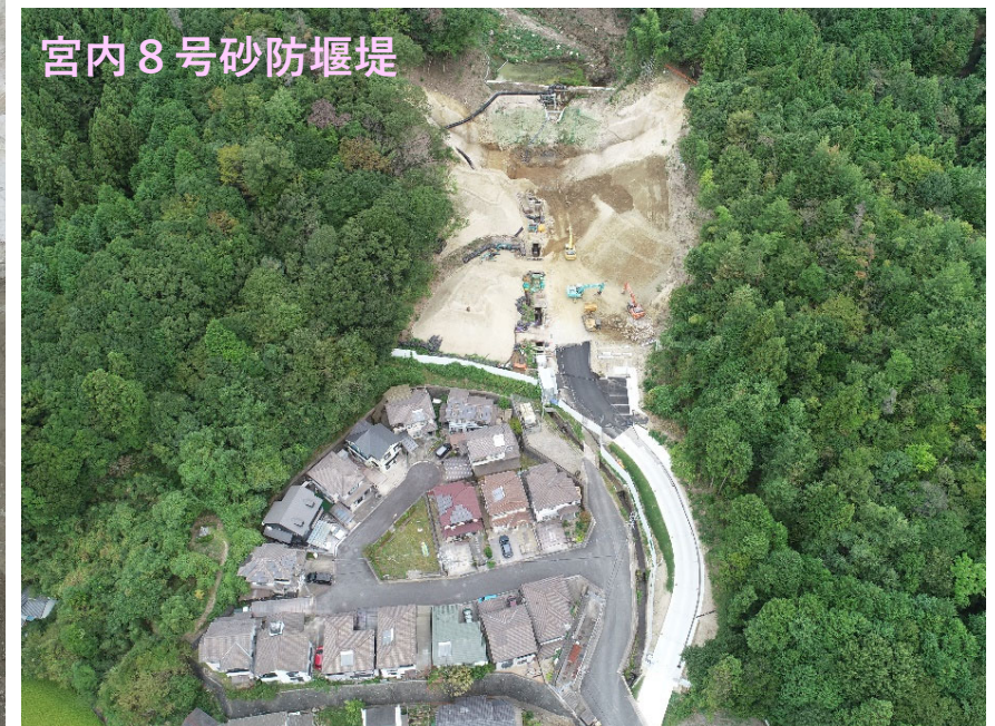
【施工状況（下流側より）】
