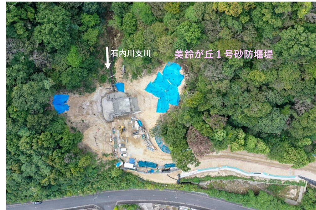
【施工状況（上空より）】
