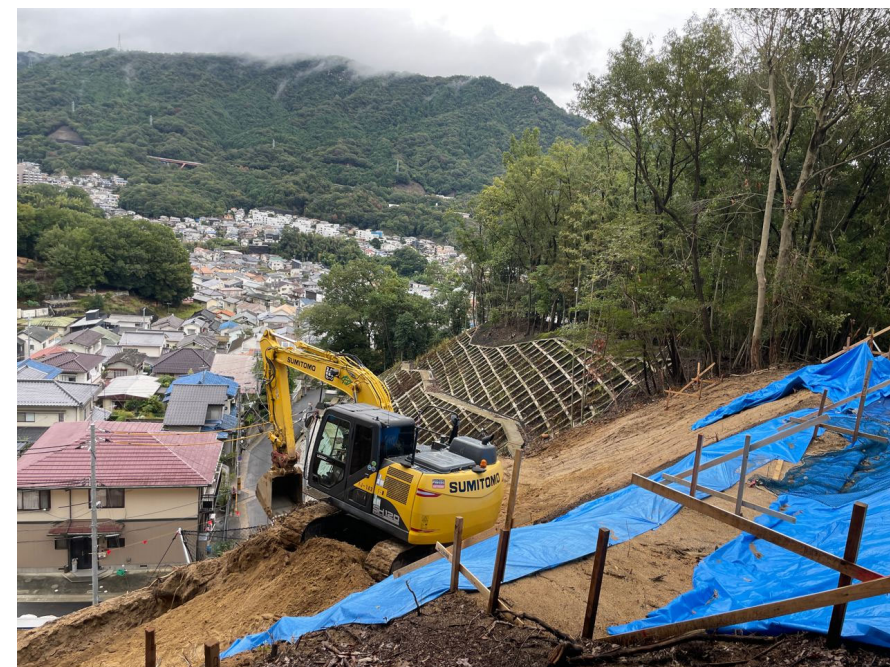
【管理用道路 施工状況】
