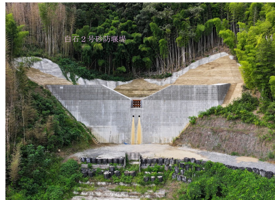
【施工状況（下流側より）】
