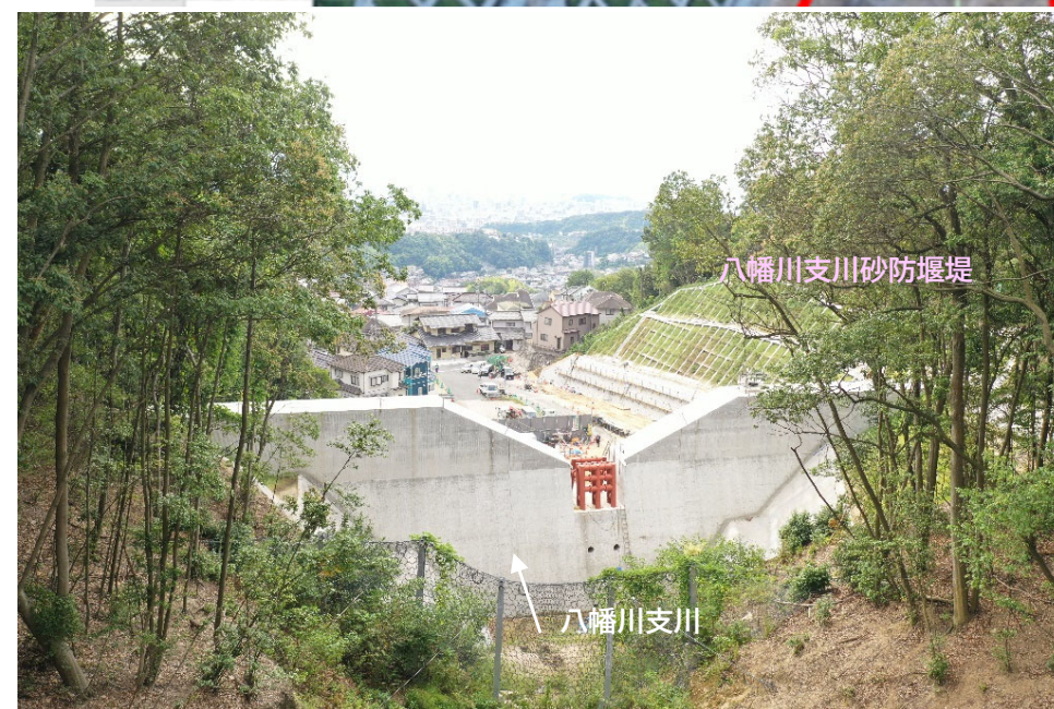
【施工状況（上流側より）】
