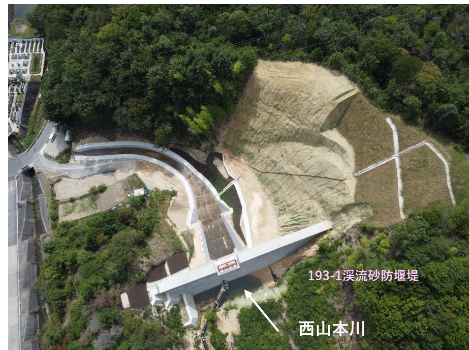
【堰堤上空からの施工状況】
