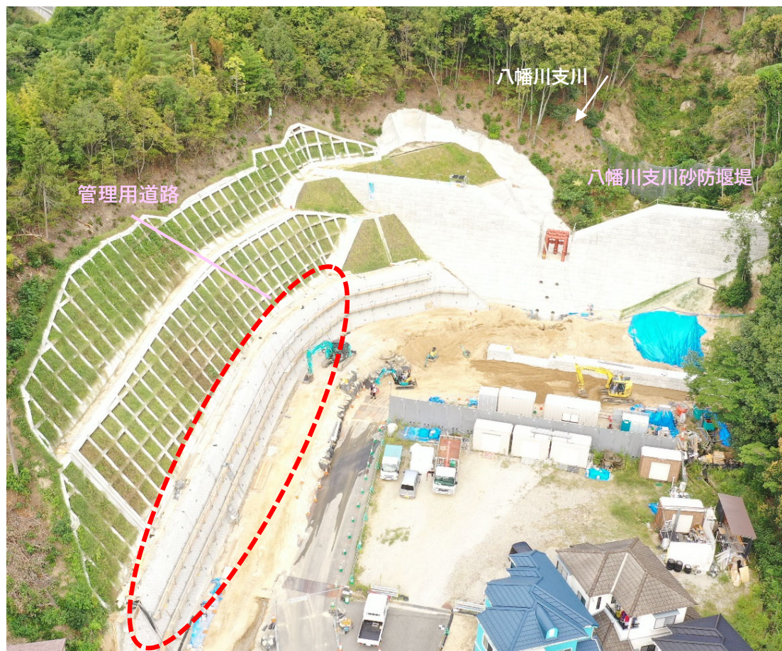
【施工状況（下流側より）】
