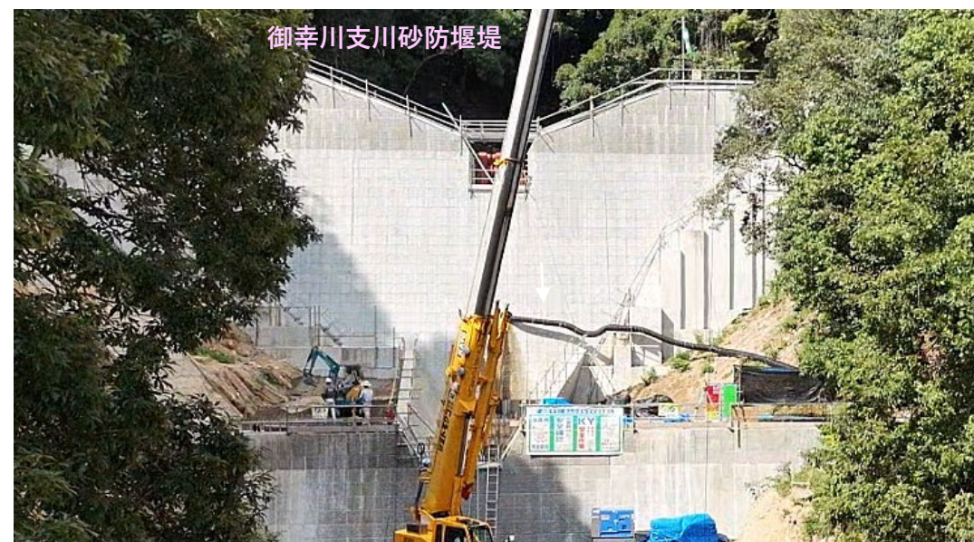
【施工箇所（下流側より）】
