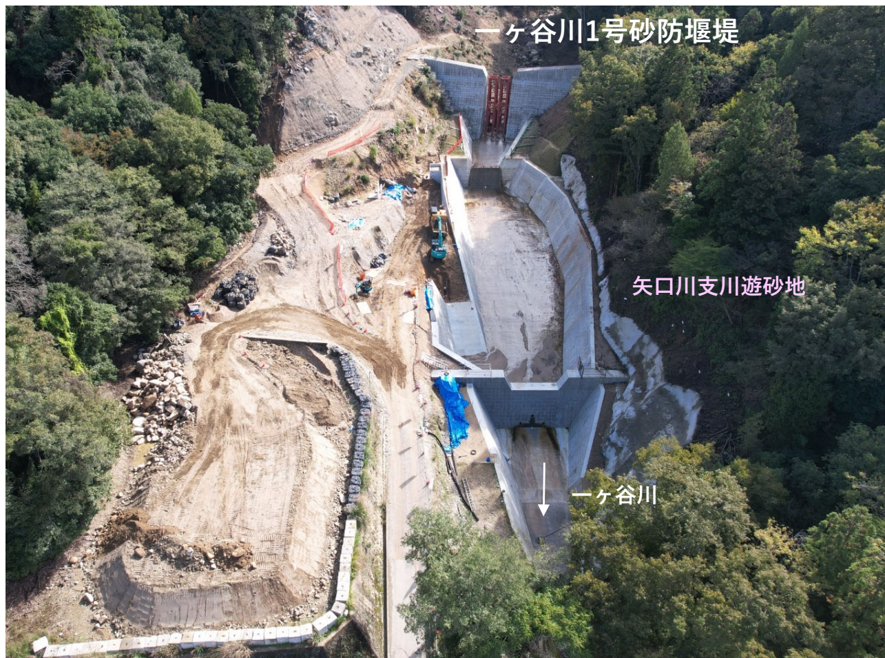
【矢口川支川遊砂地 全景】
