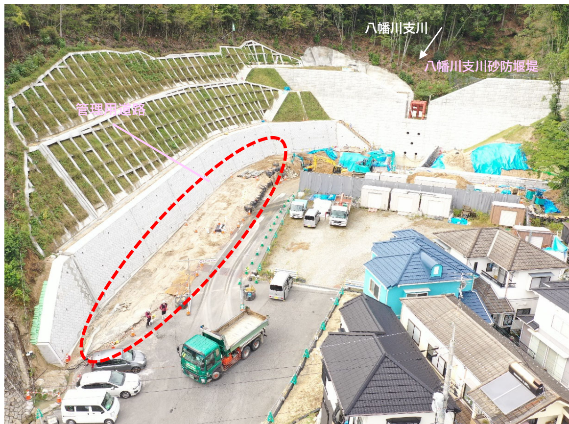
【施工状況（下流側より）】
