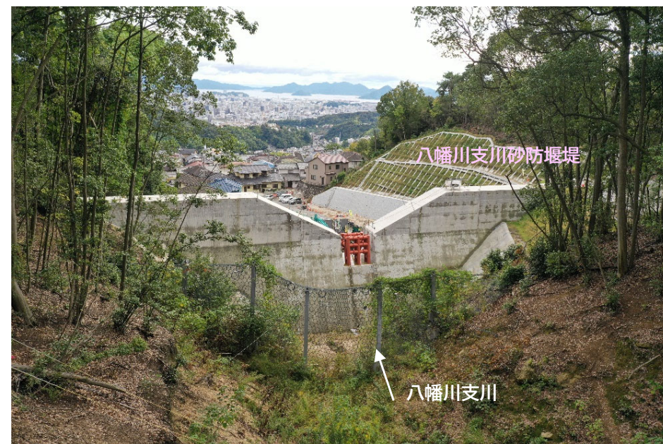
【施工状況（上流側より）】
