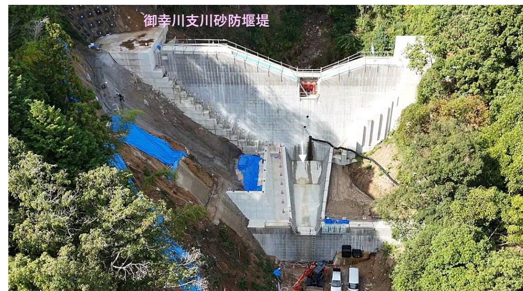
【施工箇所（下流上空より）】
