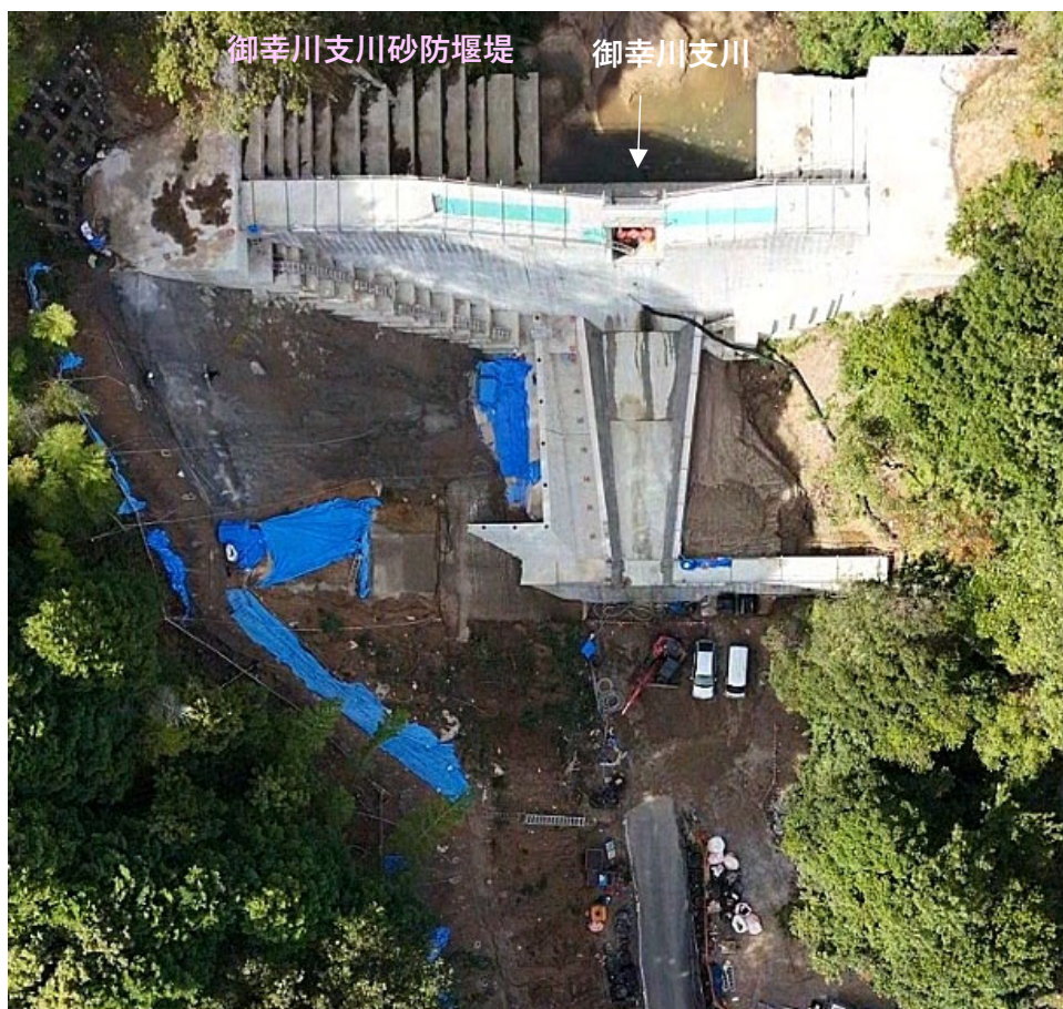
【施工状況（上空より）】
