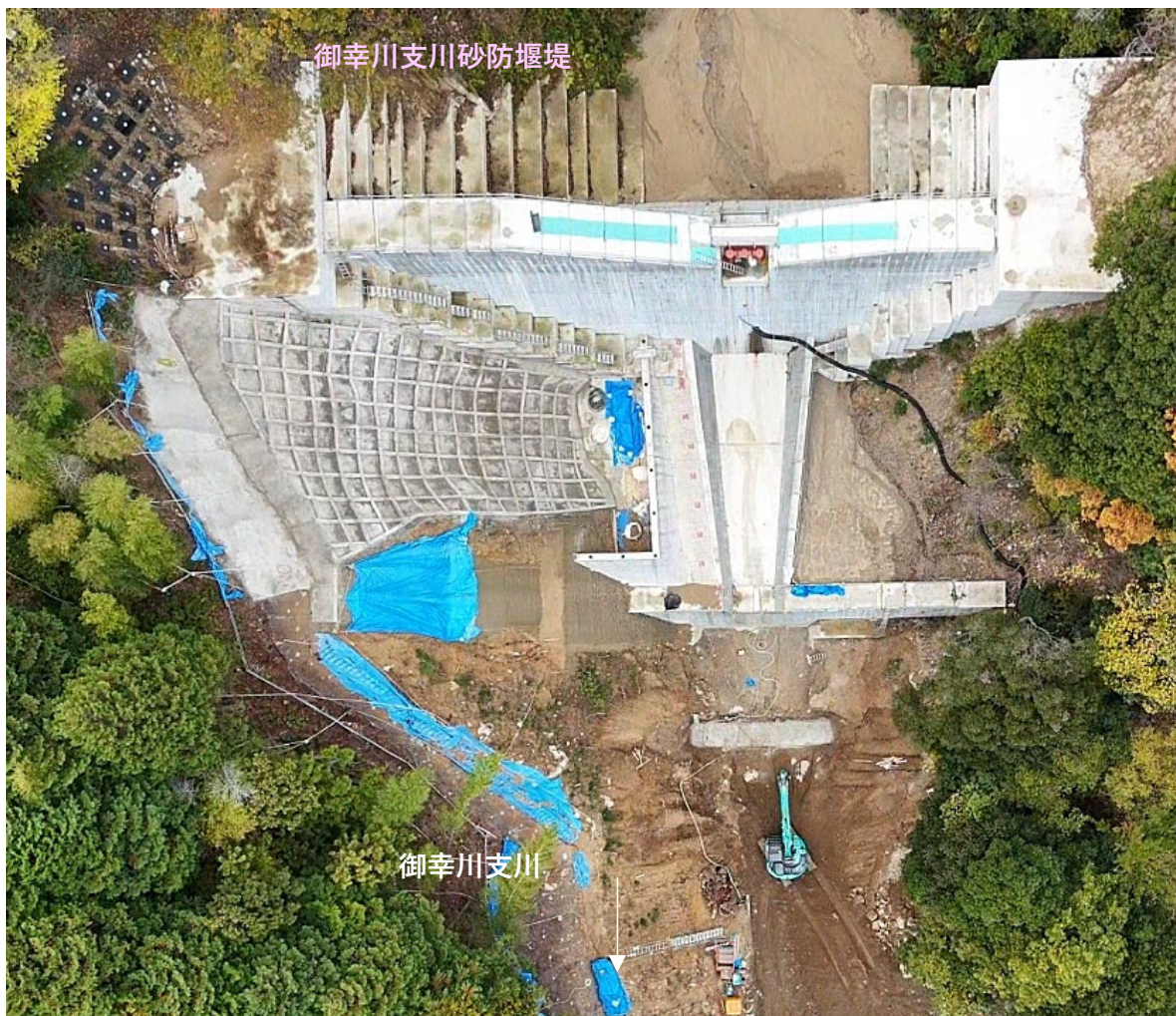
【施工状況（上空より）】
