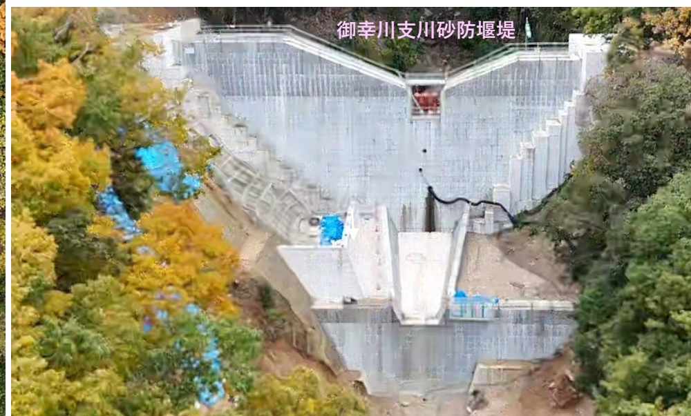
【施工箇所（下流上空より）】
