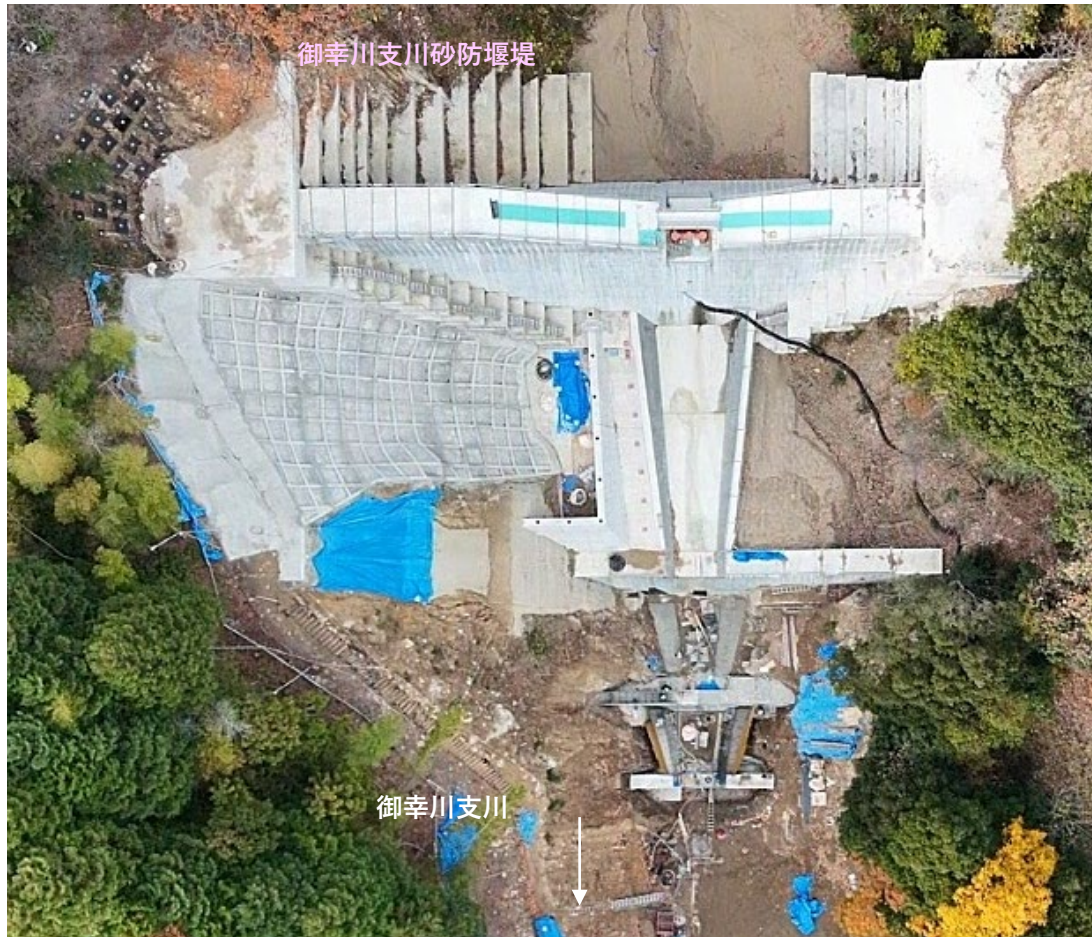
【施工状況（上空より）】
