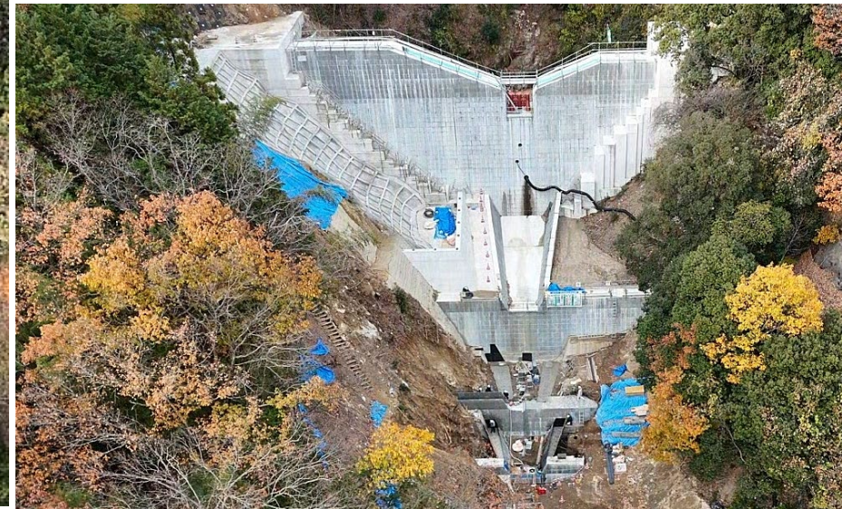
【施工状況（下流上空より）】
