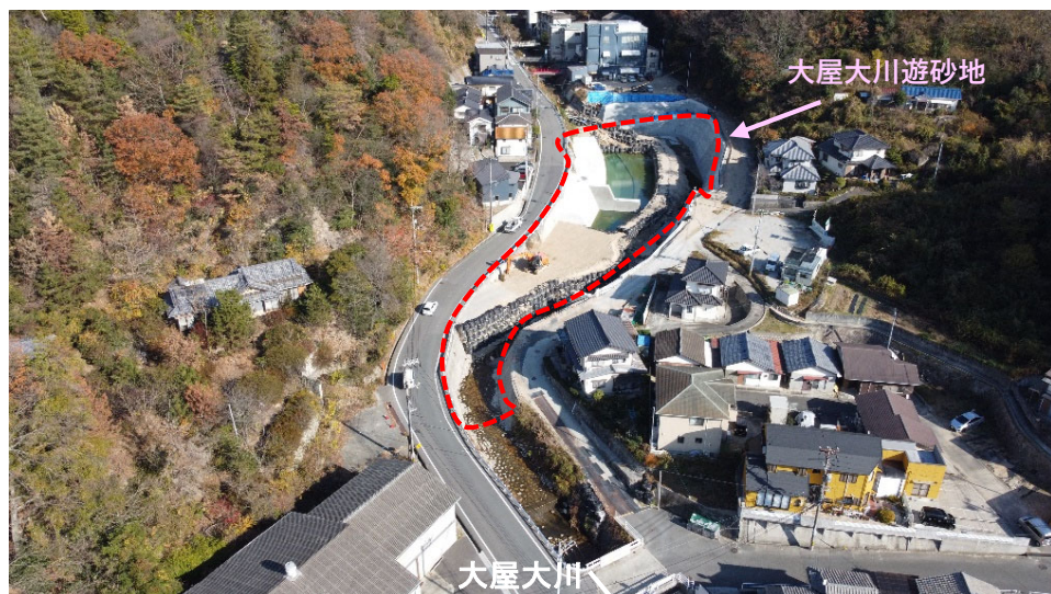
【施工状況（上空より）】
