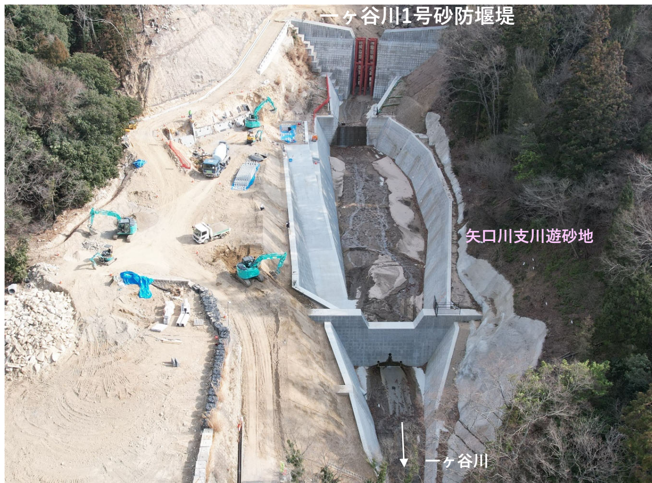
【矢口川支川遊砂地 全景】
