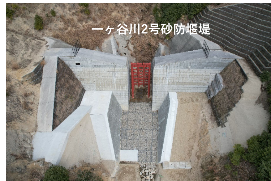
【一ヶ谷川2号砂防堰堤 全景】
