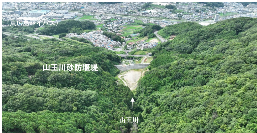
【施工状況（上空より）】
