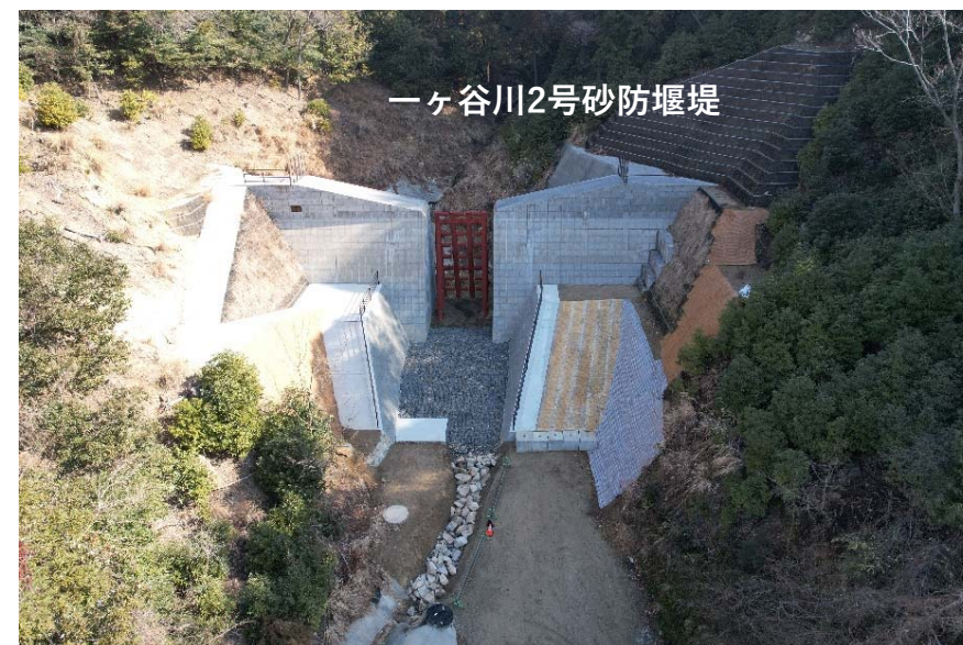
【一ヶ谷川2号砂防堰堤 全景】
