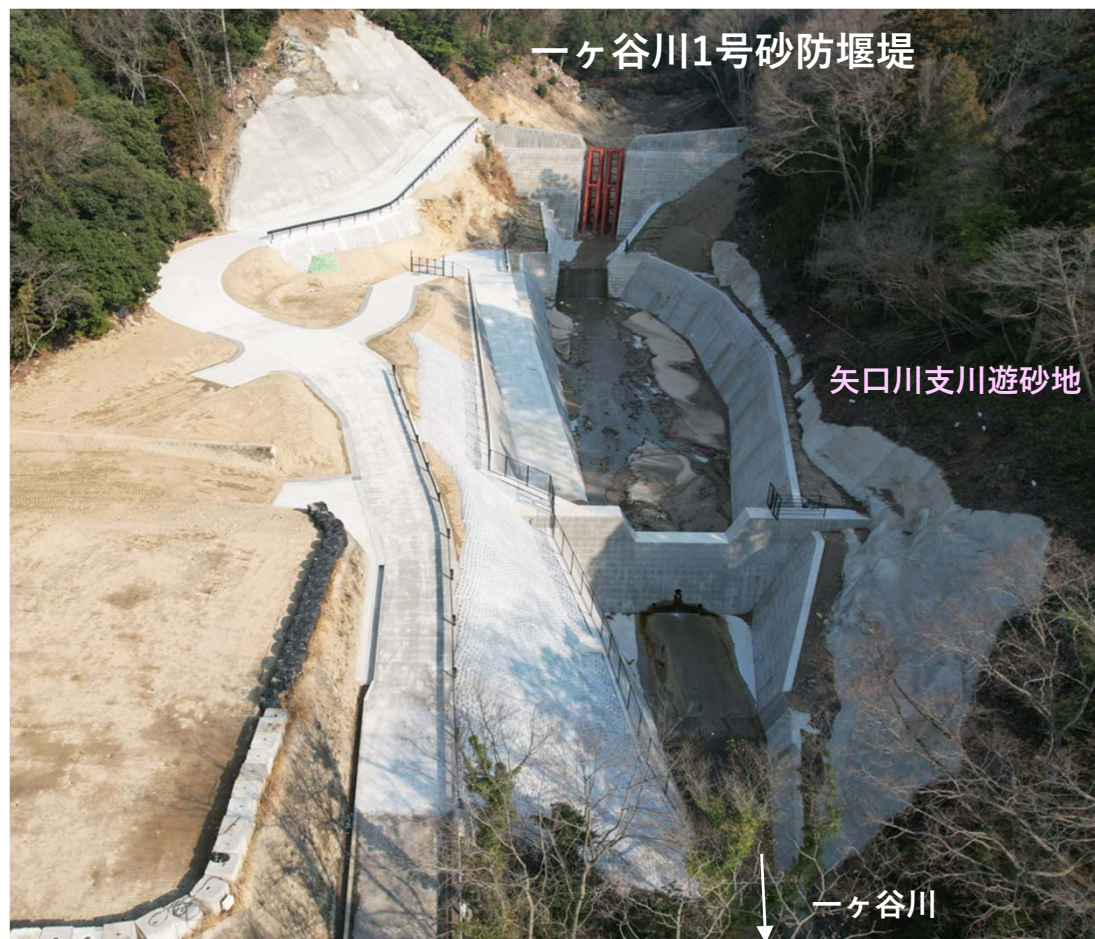
【矢口川支川遊砂地 全景】
