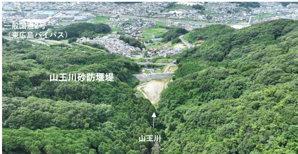
【施工状況 (上空より)】
