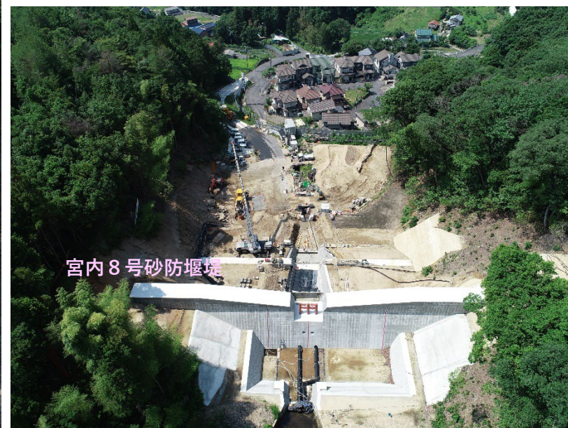
【施工状況（上流より）】
