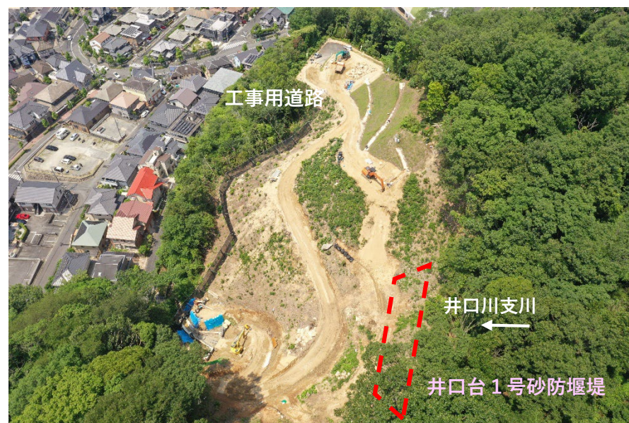
【上空より（井口台1号堰堤側から）】
