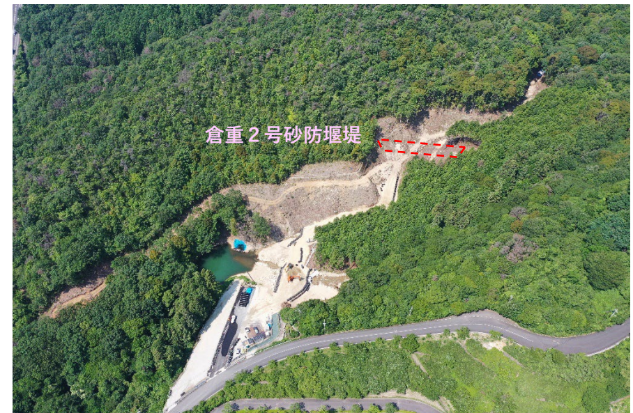
【全景 堰堤下流から】
