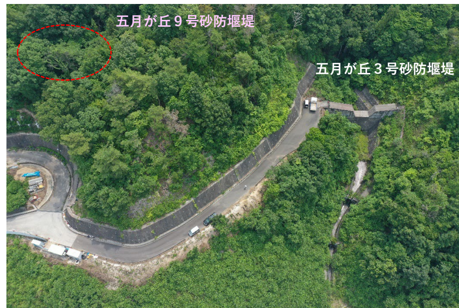
【五月が丘9号砂防堰堤 施工状況】
