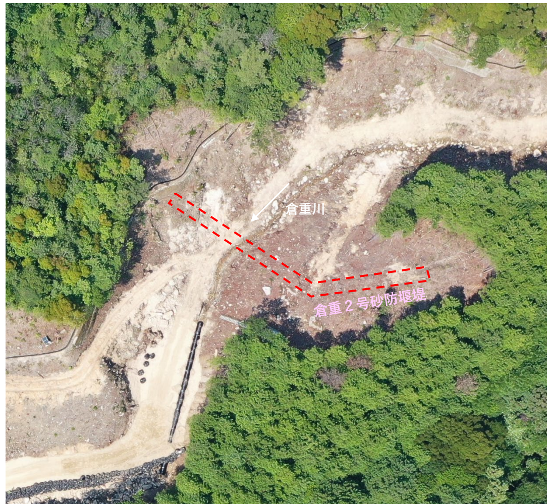
【全景 堰堤真上から】
