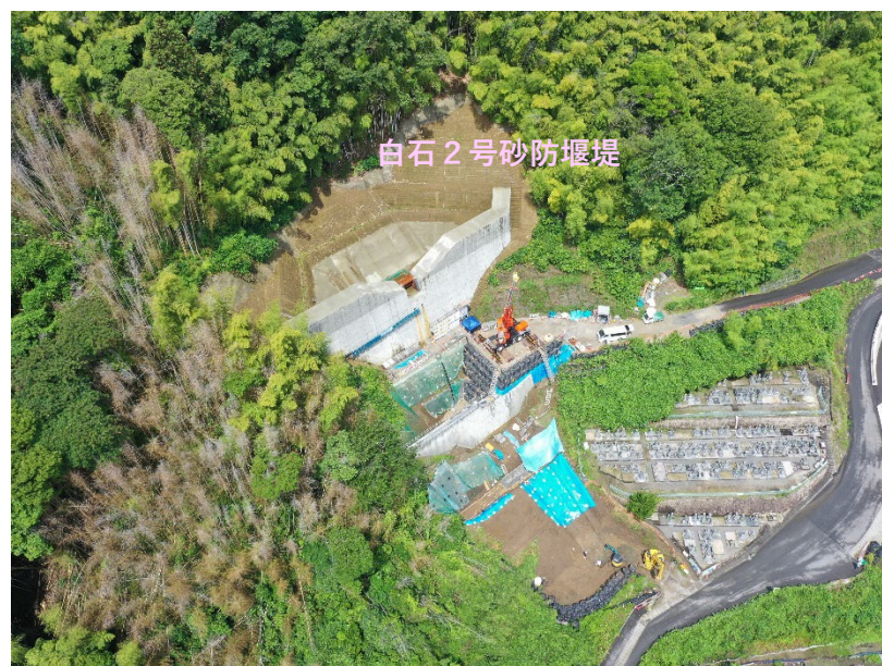
【施工状況（下流側より）】
