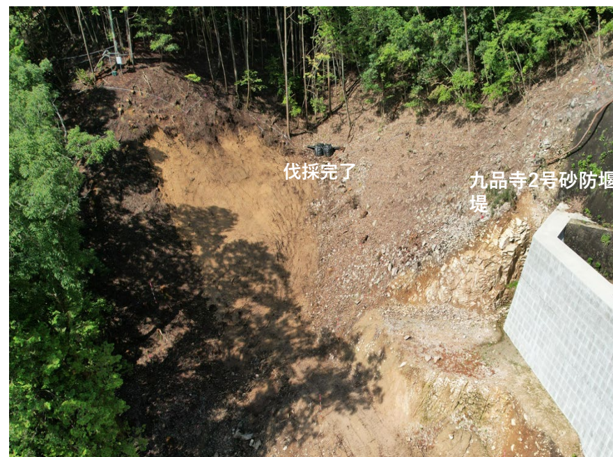
【九品寺 3 号砂防堰堤 伐採箇所 施工状況】
