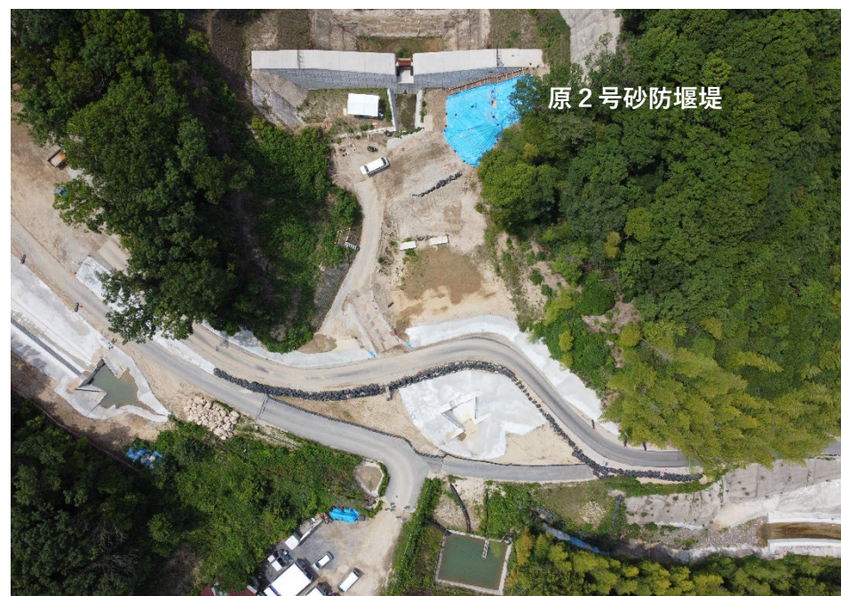
【全景（原2号砂防堰堤下流）】
