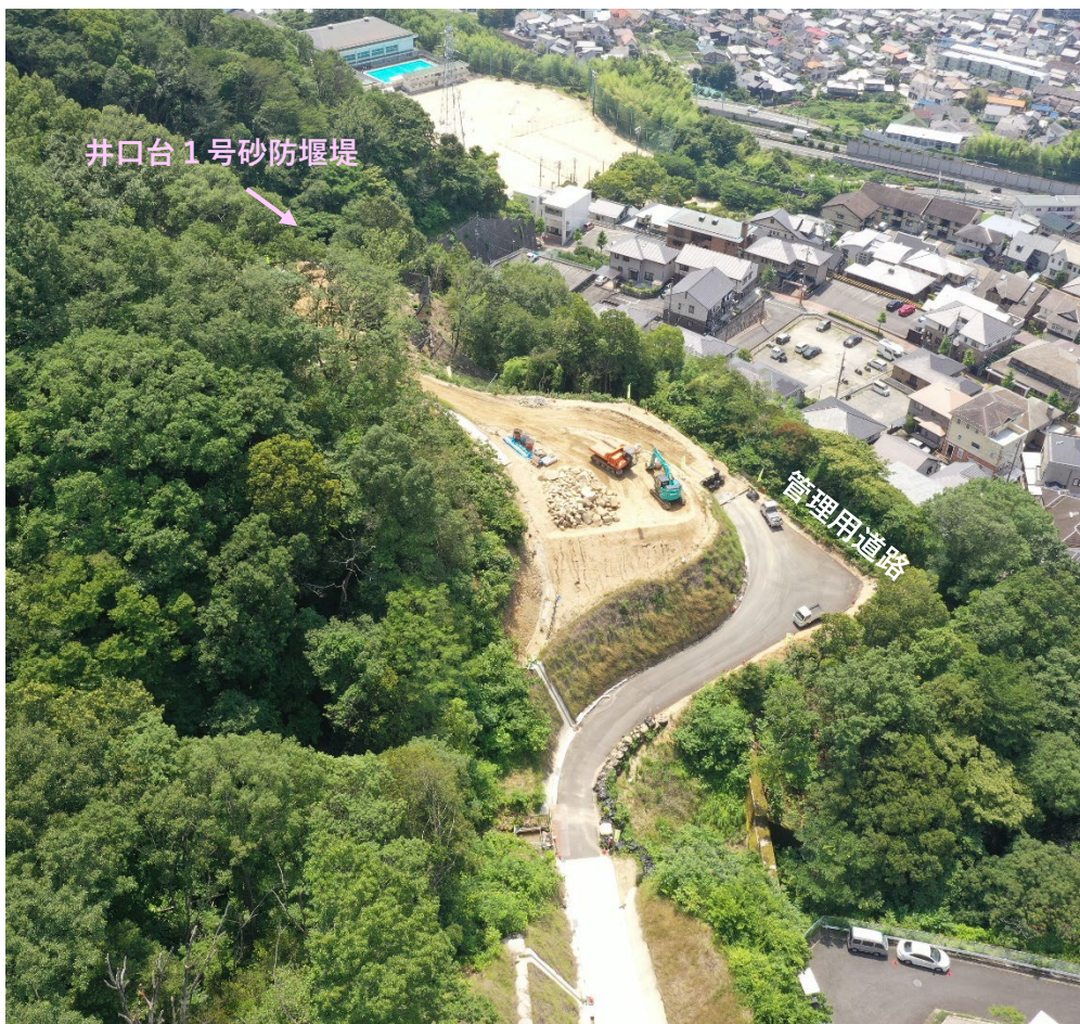
【上空より（井口台1号管理道側から）】
