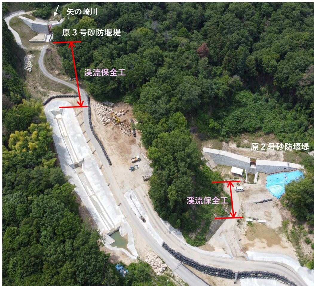
【全景（原3号・2号砂防堰堤下流）】
