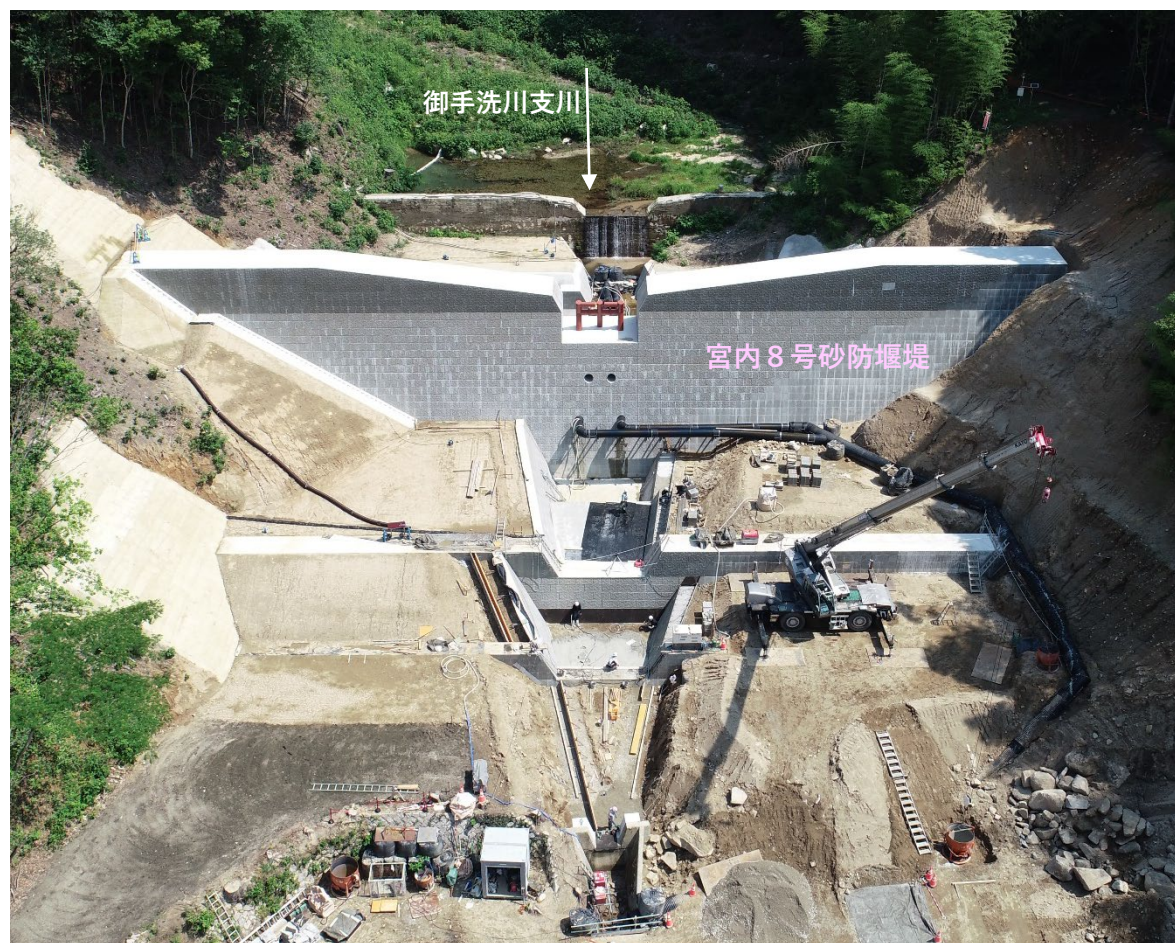
【施工状況（下流より）】
