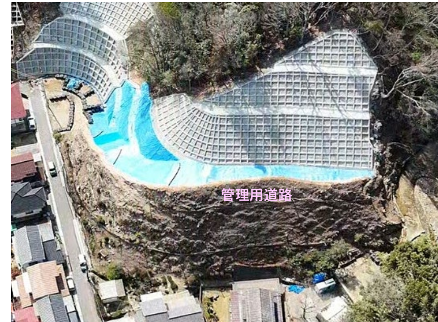
【管理用道路 施工状況】
