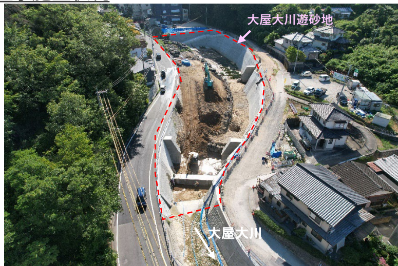
【施工状況（下流より）】
