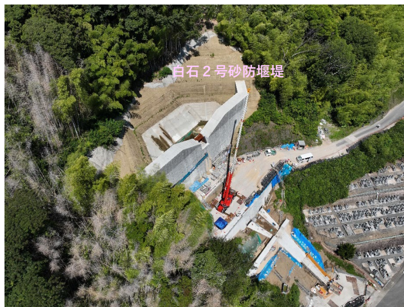
【施工状況（下流側より）】
