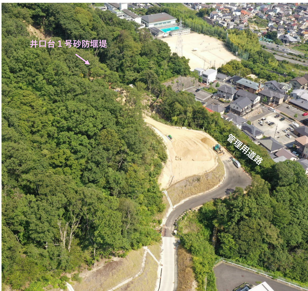
【上空より（井口台1号管理道側から）】
