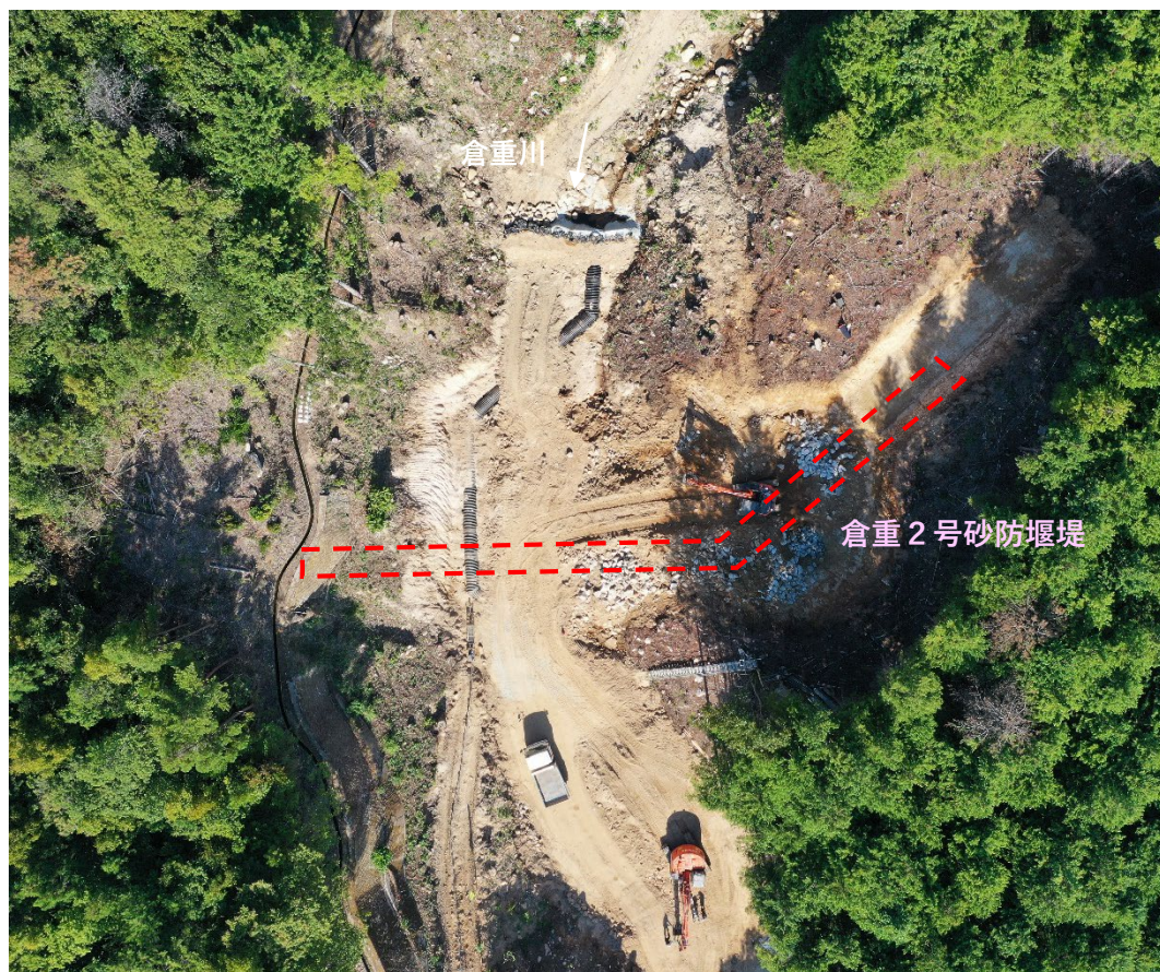
【全景 堰堤真上から】
