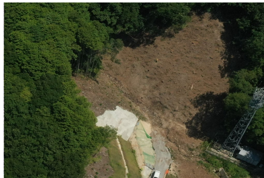
【 掘削箇所 伐採完了】
