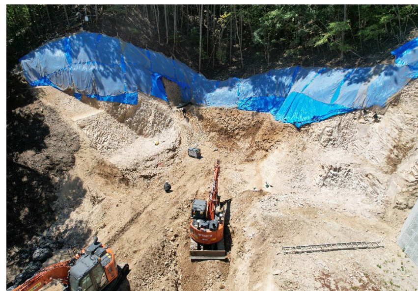
【九品寺 3 号砂防堰堤 掘削箇所 施工状況】
