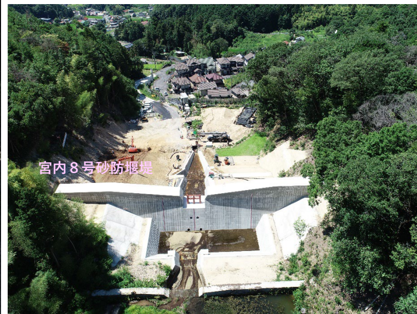
【施工状況（上流より）】
