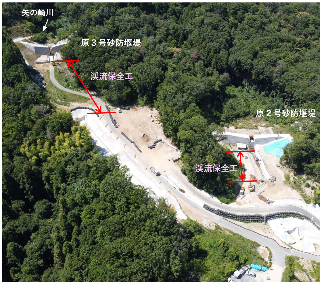
【全景（原3号・2号砂防堰堤下流）】
