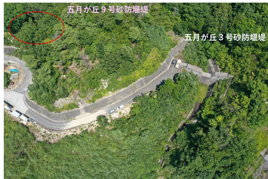
【五月が丘9号砂防堰堤 施工状況】
