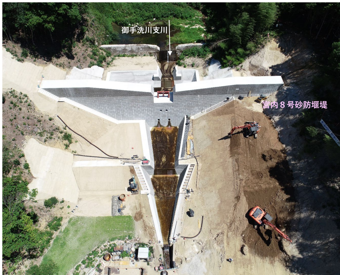
【施工状況（下流より）】
