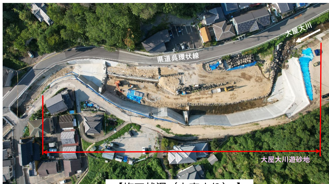
【施工状況（上空より）】
