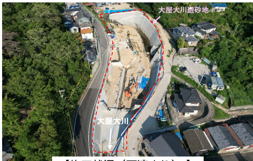
【施工状況（下流より）】
