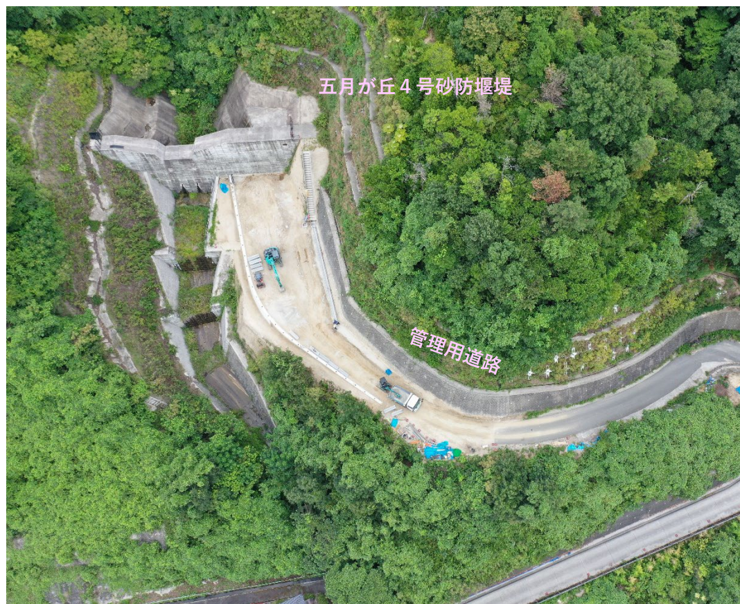
【五月が丘4号砂防堰堤 施工状況】
