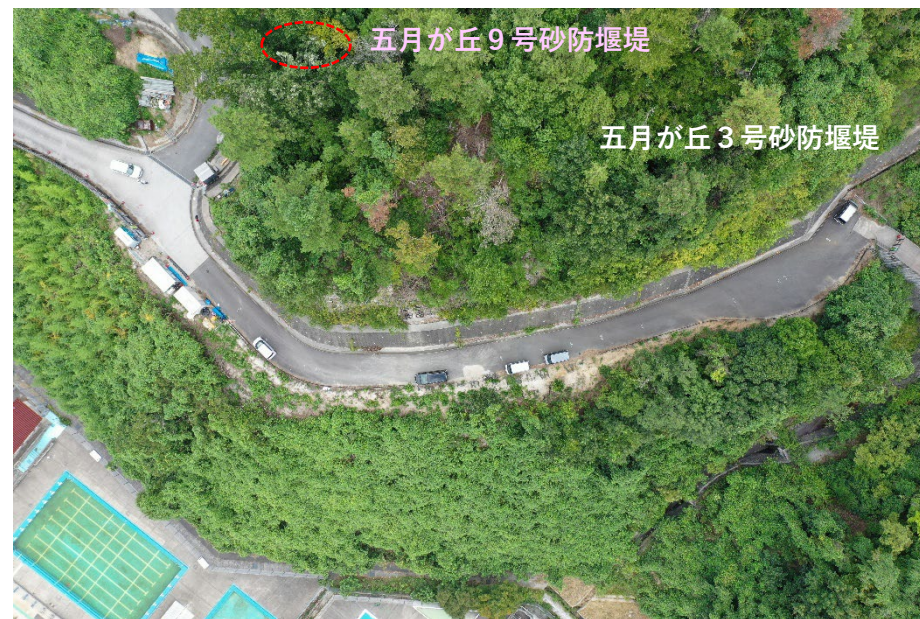
【五月が丘9号砂防堰堤 施工状況】
