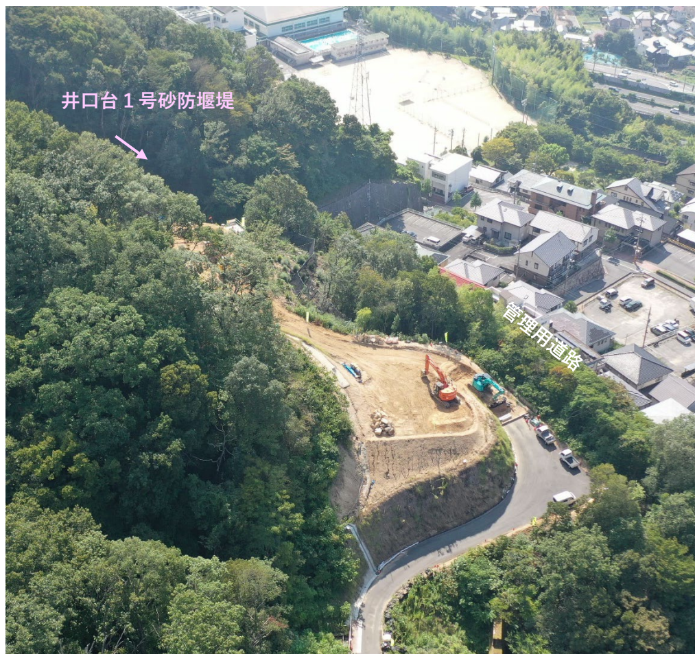
【上空より（井口台1号管理道側から）】
