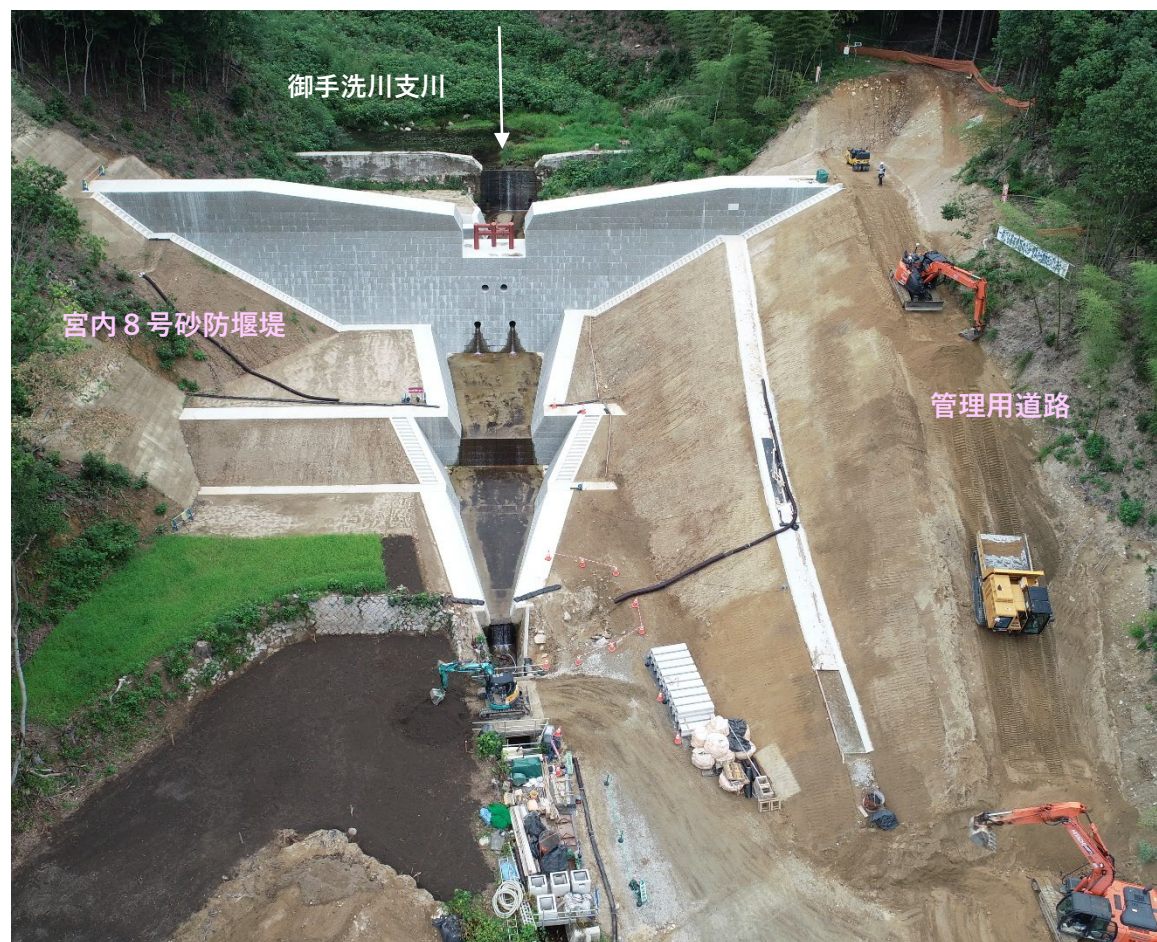
【施工状況（下流より）】
