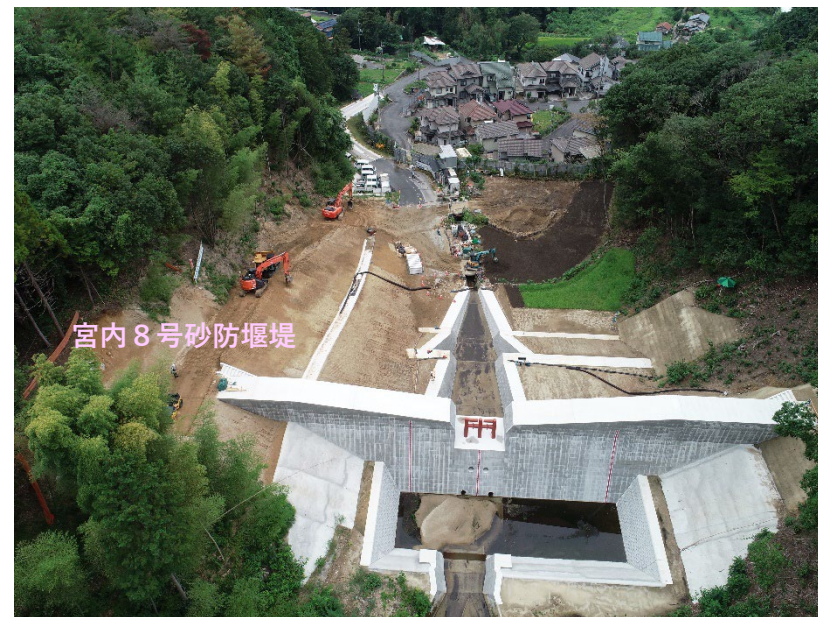
【施工状況（上流より）】
