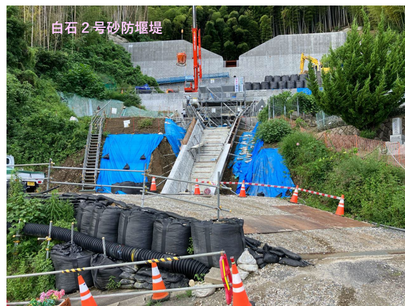
【施工状況（下流側より）】
