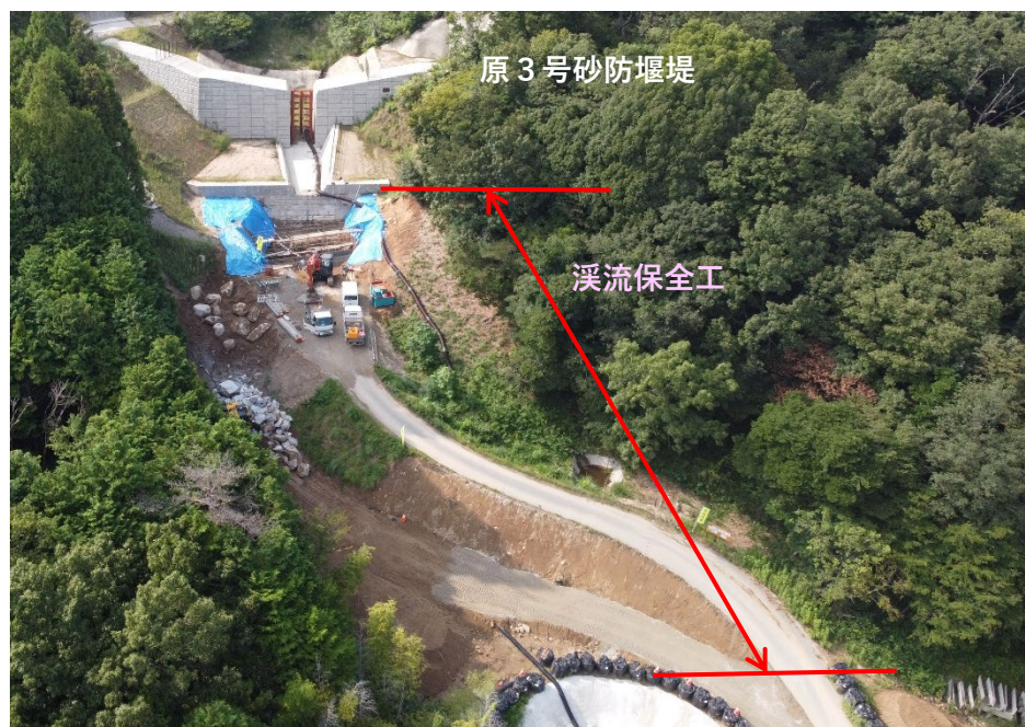
【全景（原3号砂防堰堤下流）】
