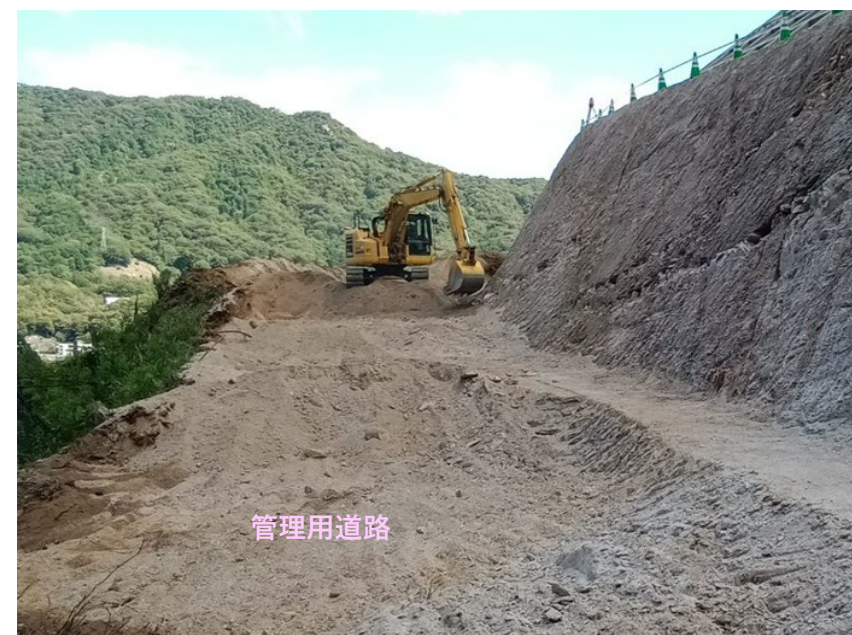
【管理用道路 施工状況】
