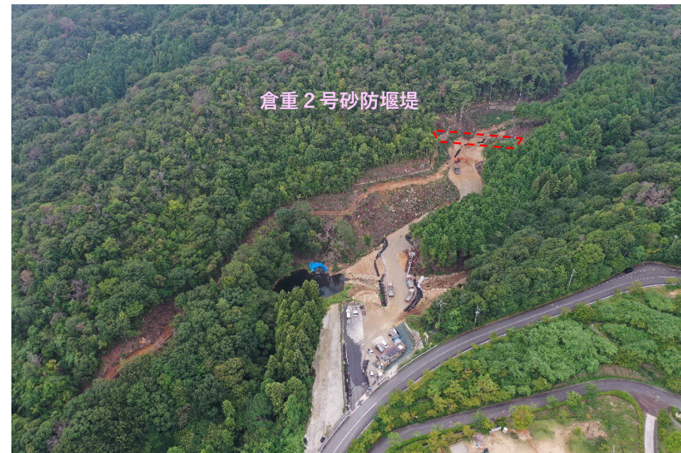
【全景 堰堤下流から】
