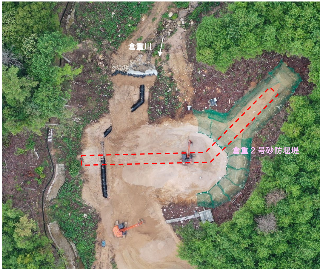
【全景 堰堤真上から】
