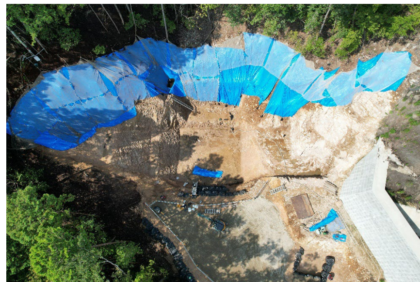
【九品寺 3 号砂防堰堤 掘削完了】
