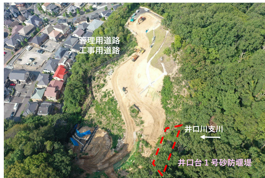
【上空より（井口台1号堰堤側から）】
