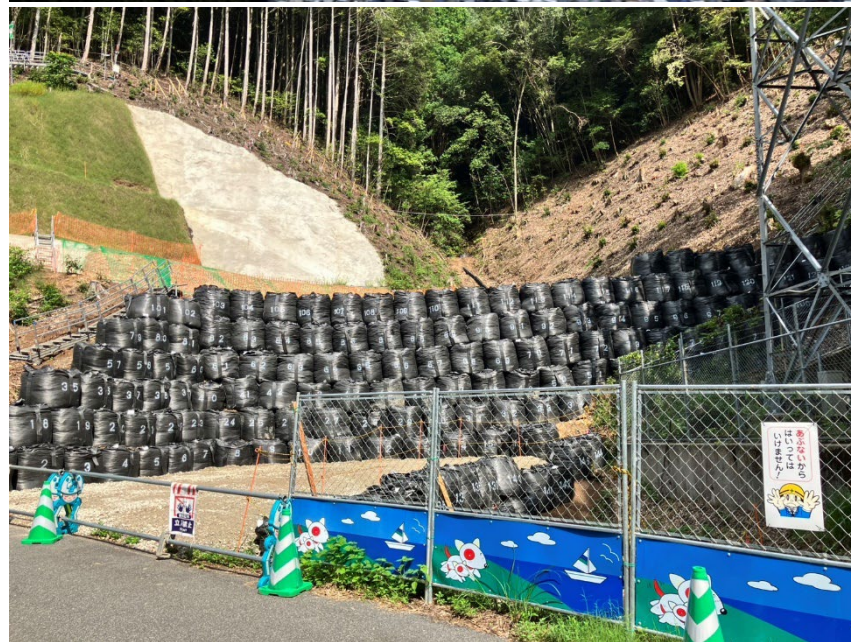
【 仮設ヤード完了】
