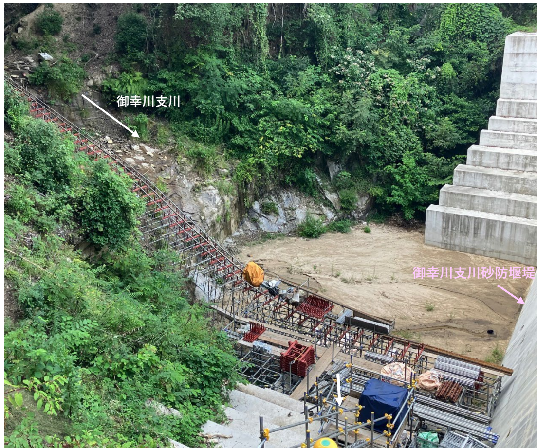
【施工状況（御幸川支川砂防堰堤裏）】
