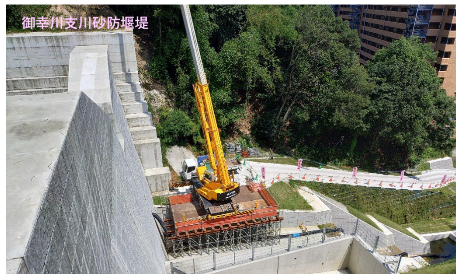
【施工状況（御幸川支川砂防堰堤前）】
