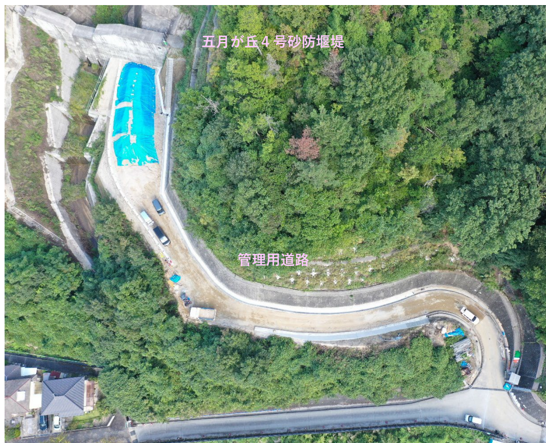
【五月が丘4号砂防堰堤 施工状況】
