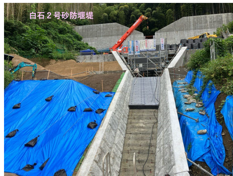
【施工状況（下流側より）】
