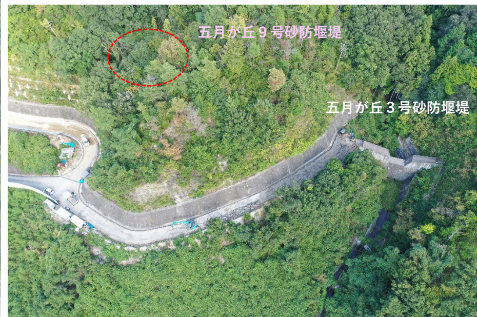
【五月が丘9号砂防堰堤 施工状況】
