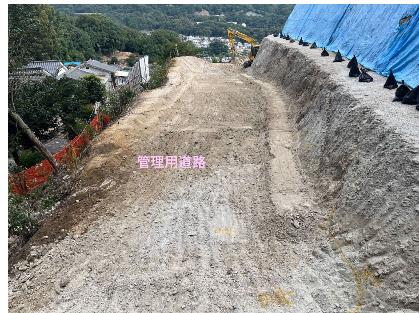
【管理用道路 施工状況】
