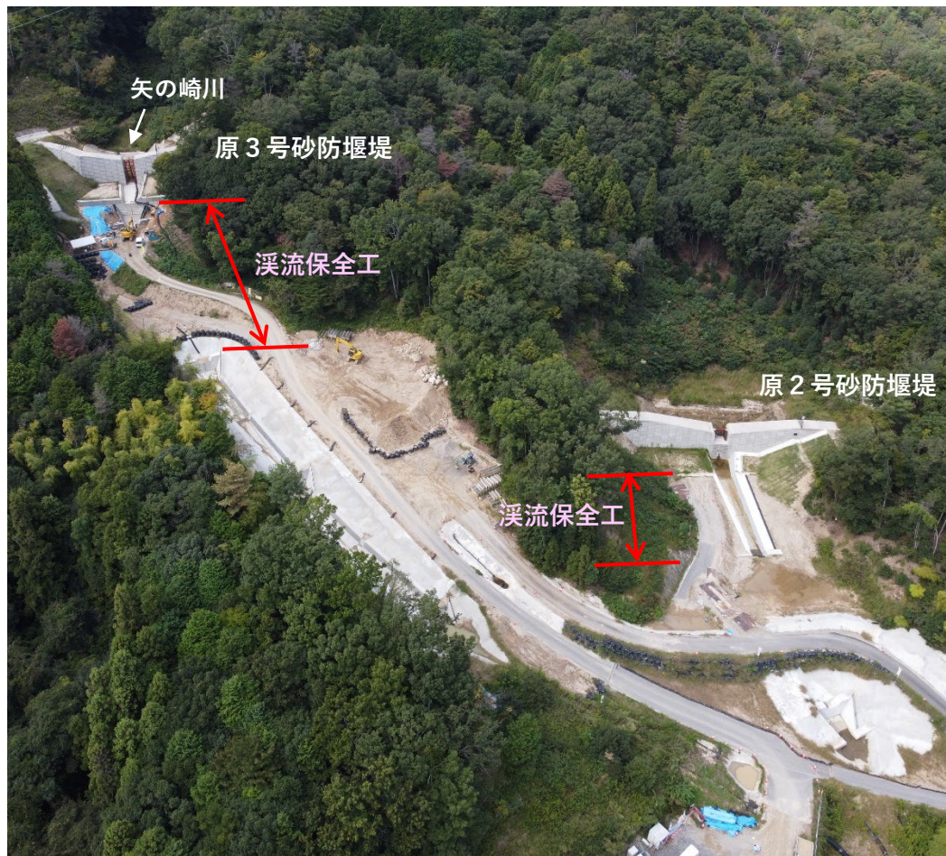
【全景（原3号・2号砂防堰堤下流）】
