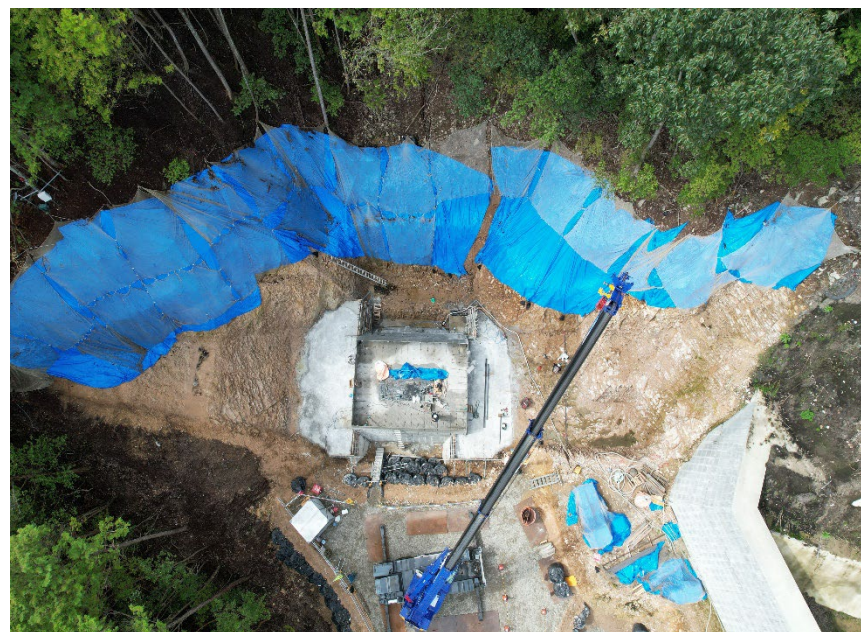
【砂防堰堤 施工状況】
