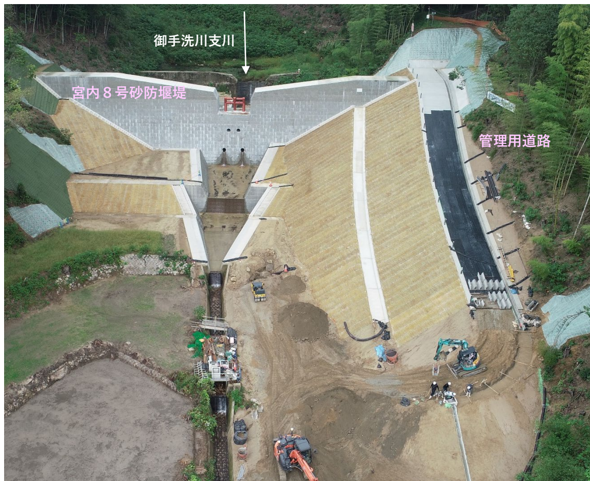
【施工状況（下流より）】
