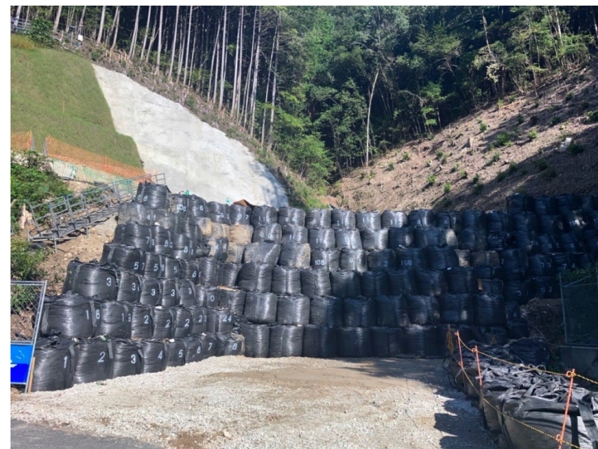
【 積み込みヤード完了】
