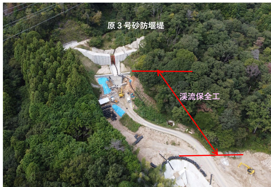
【全景（原3号砂防堰堤下流）】
