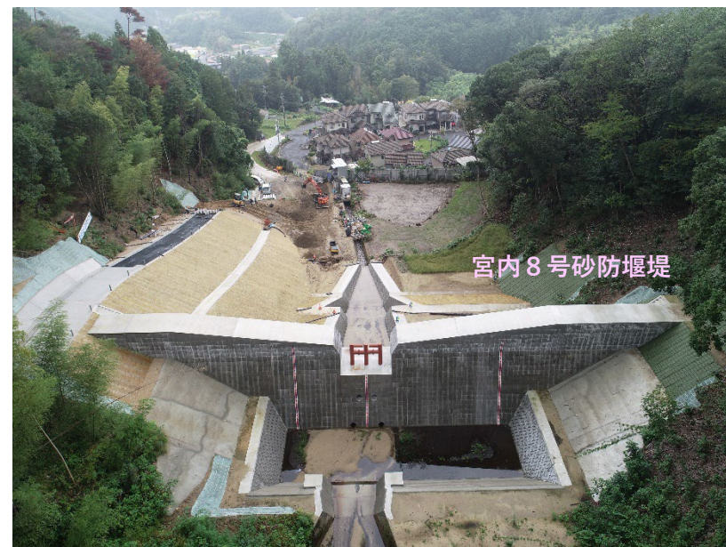
【施工状況（上流より）】
