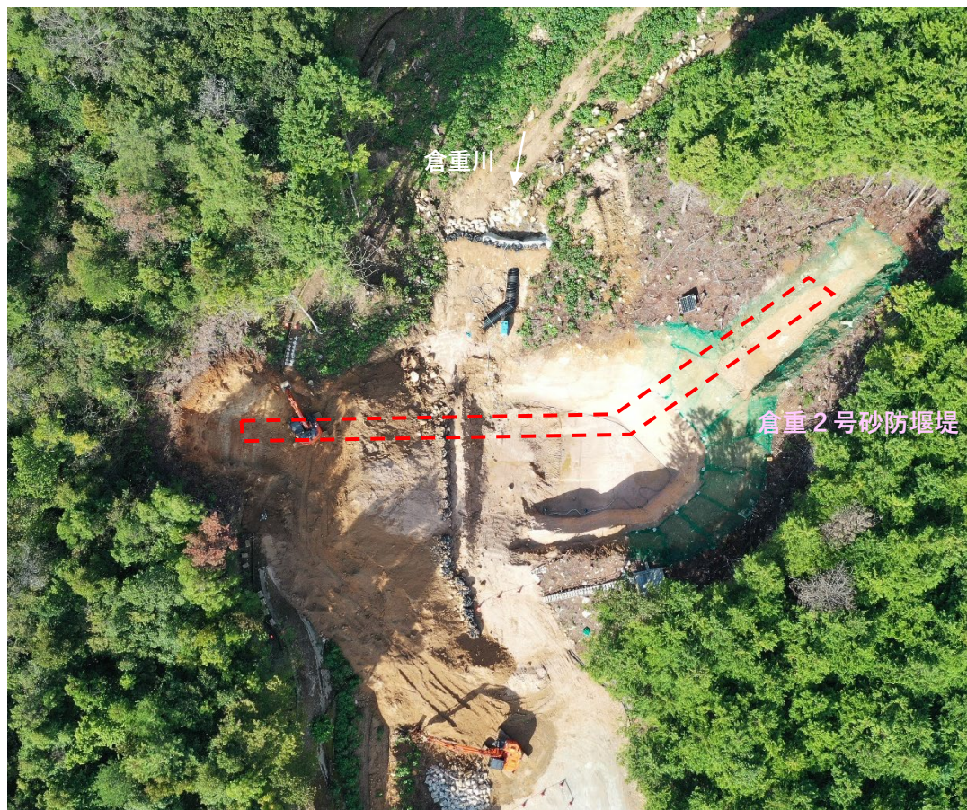
【全景 堰堤真上から】
