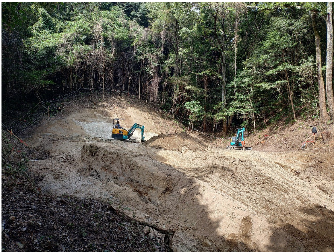
【施工状況（御幸川支川砂防堰堤裏）】
