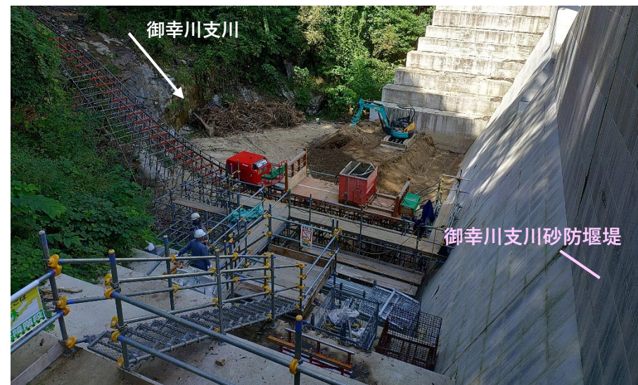
【施工状況（御幸川支川砂防堰堤前）】
