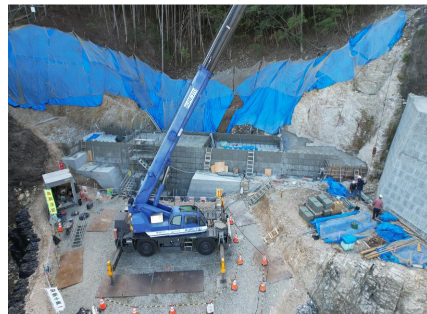
【砂防堰堤 施工状況】
