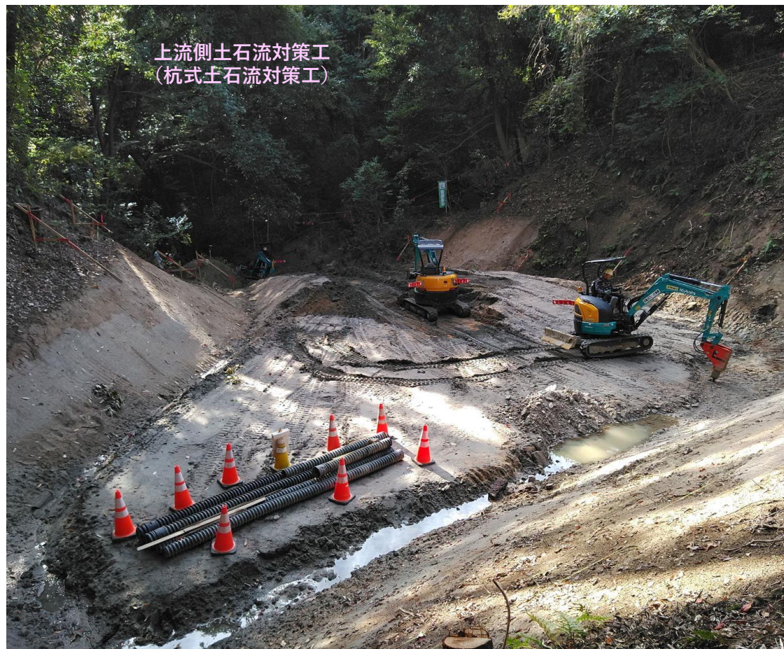
【施工状況（御幸川支川砂防堰堤上流側土石流対策工）】
