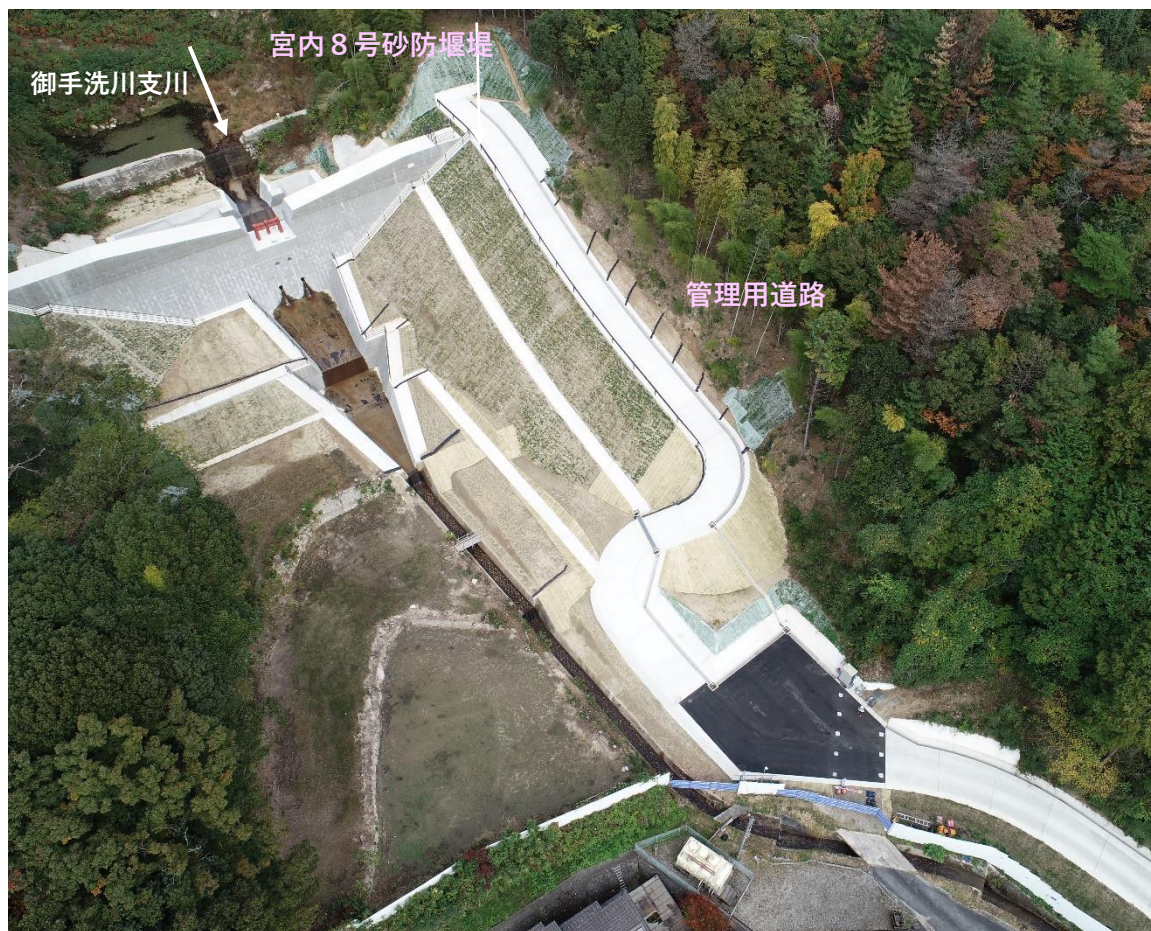
【施工状況（上空より）】
