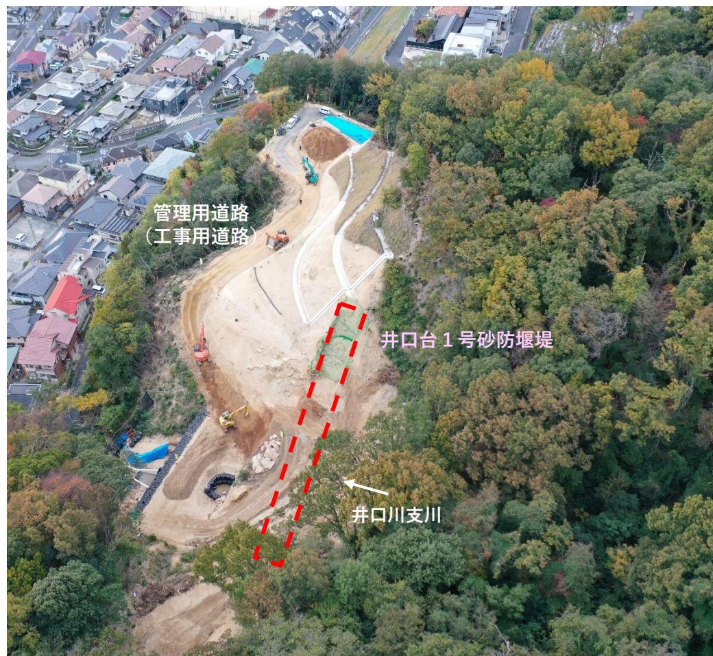
【上空より(堰堤左岸側から)】
