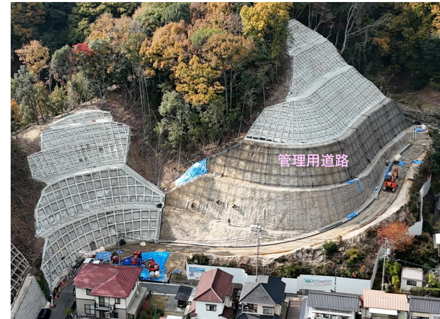
【管理用道路 施工状況】
