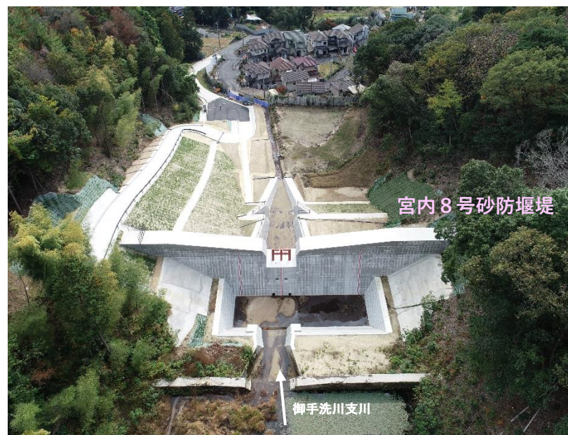
【施工状況（上空上流より）】
