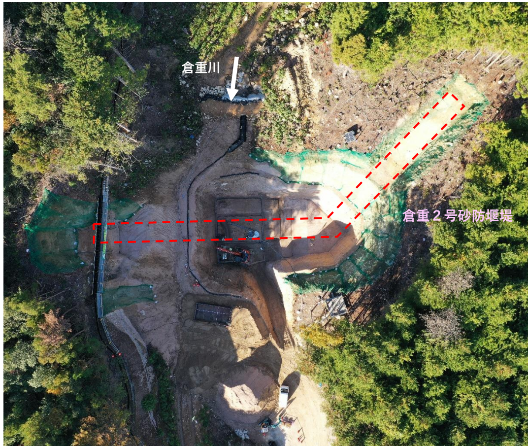
【全景 堰堤真上から】
