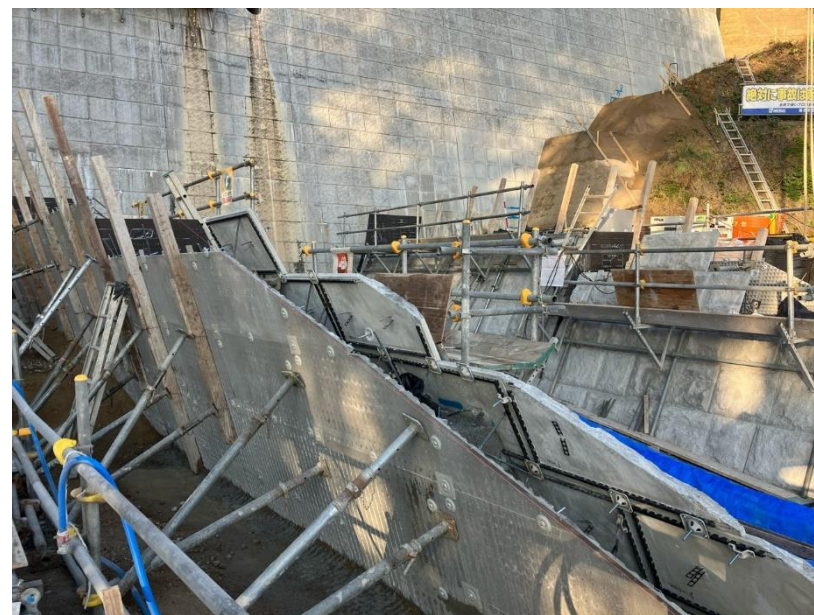
【施工状況（本堤前側壁工施工）】
