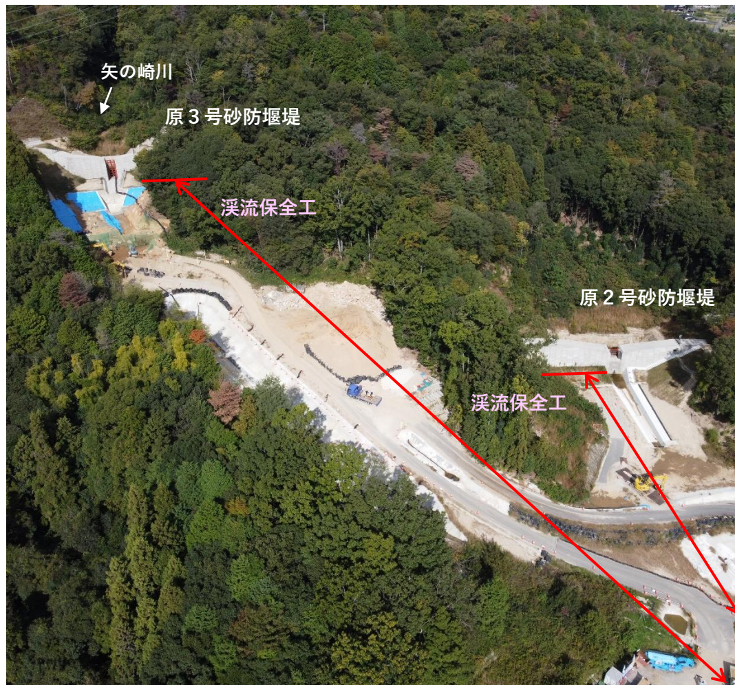
【全景（原3号・2号砂防堰堤下流）】
