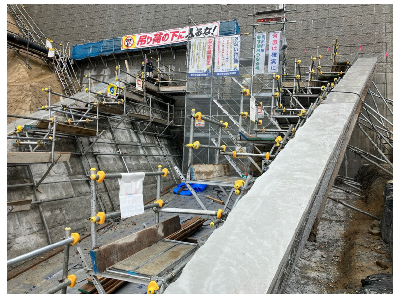
【施工状況（本堤前側壁工施工）】
