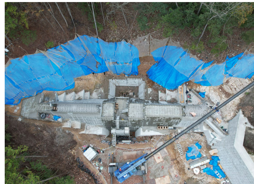
【砂防堰堤 鋼製堰堤工施工状況】
