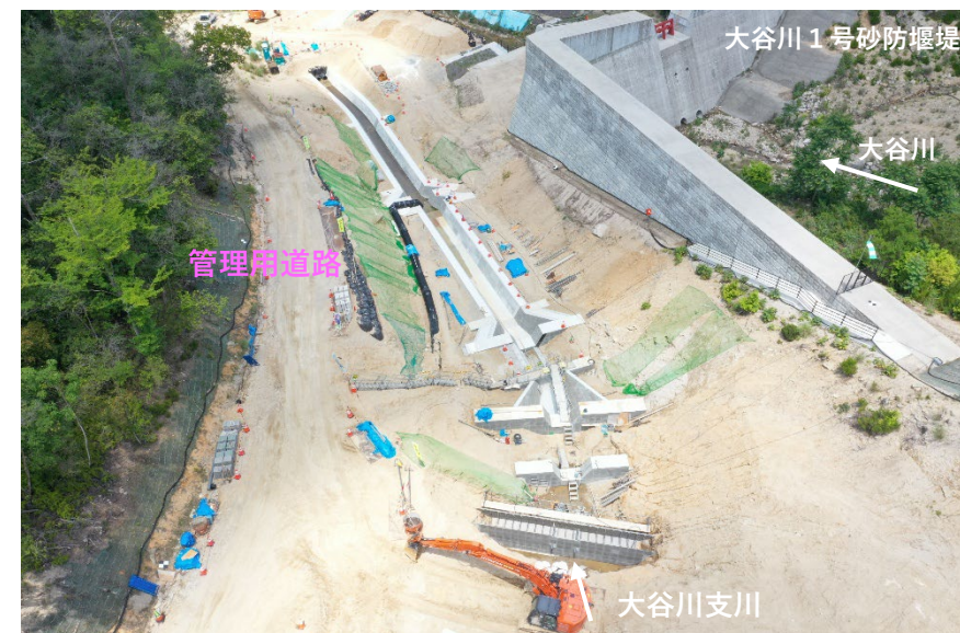
【施工状況②】
