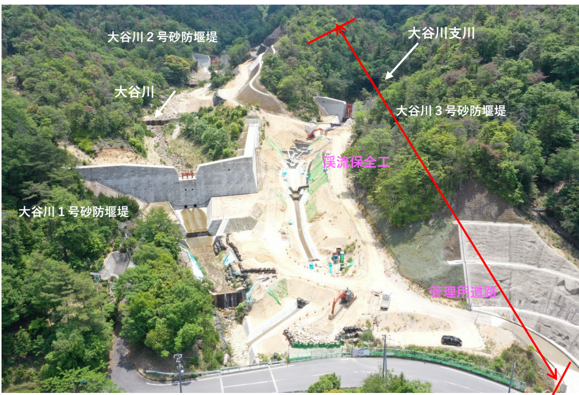
【施工状況①】
