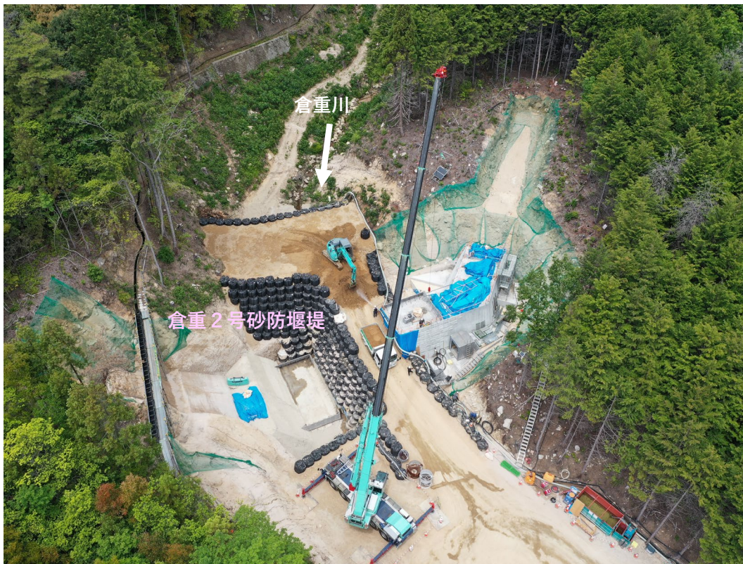
【全景 堰堤真上から】
