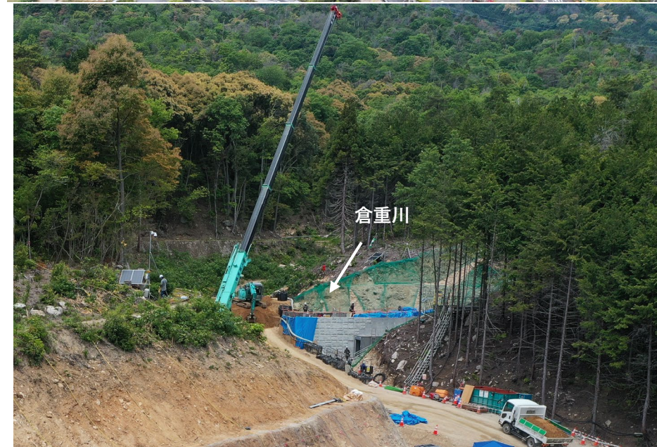
【施工状況（堰堤部施工状況）】
