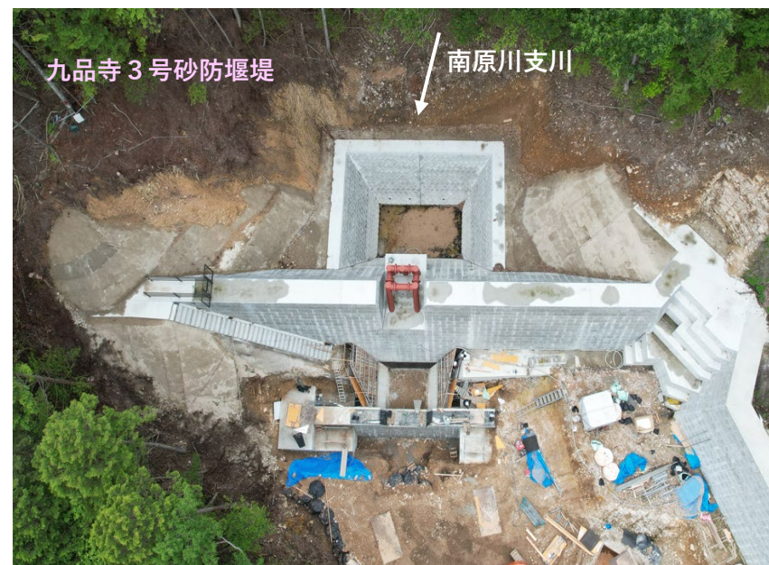
【砂防堰堤 堰堤上流側施工状況】
