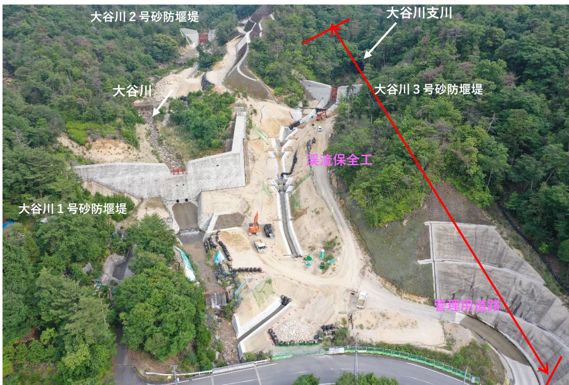
【施工状況①】
