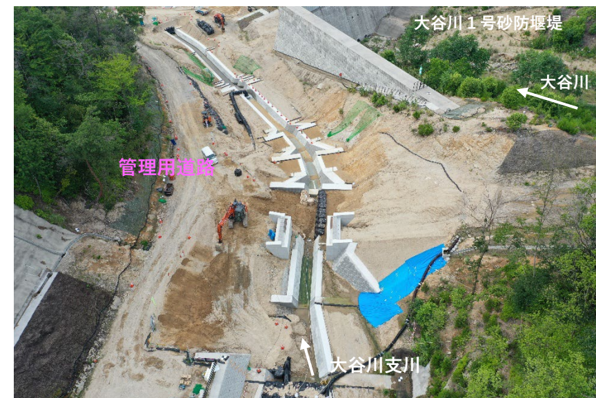
【施工状況②】
