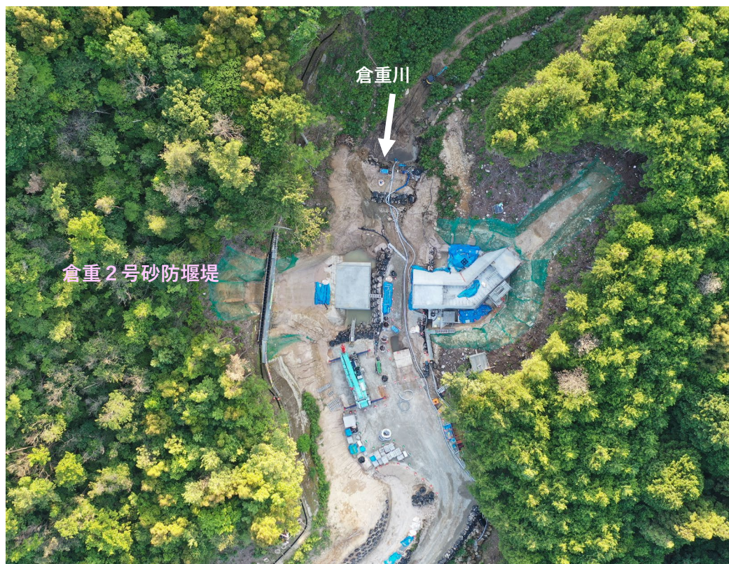
【全景 堰堤真上から】
