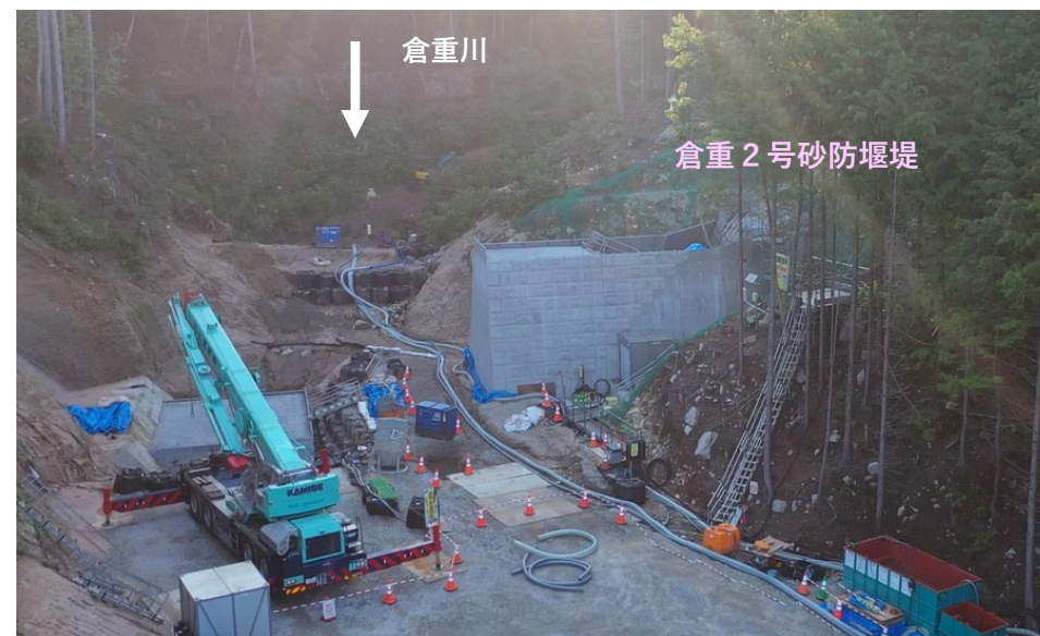
【施工状況（堰堤部施工状況）】
