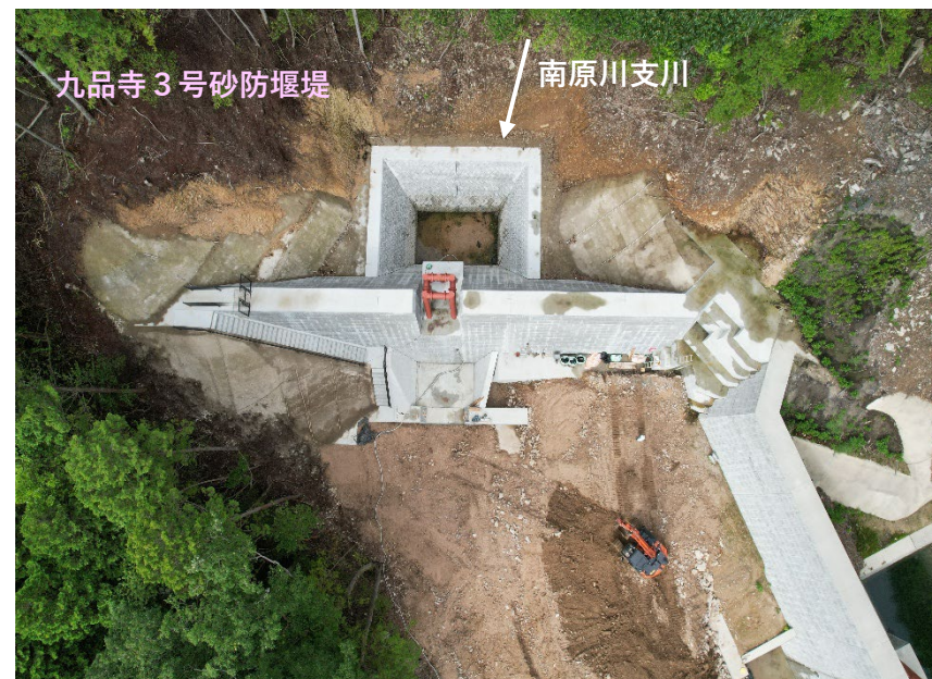
【砂防堰堤 堰堤上流側施工状況】
