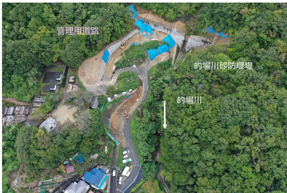
【砂防堰堤全景（下流側より）】
