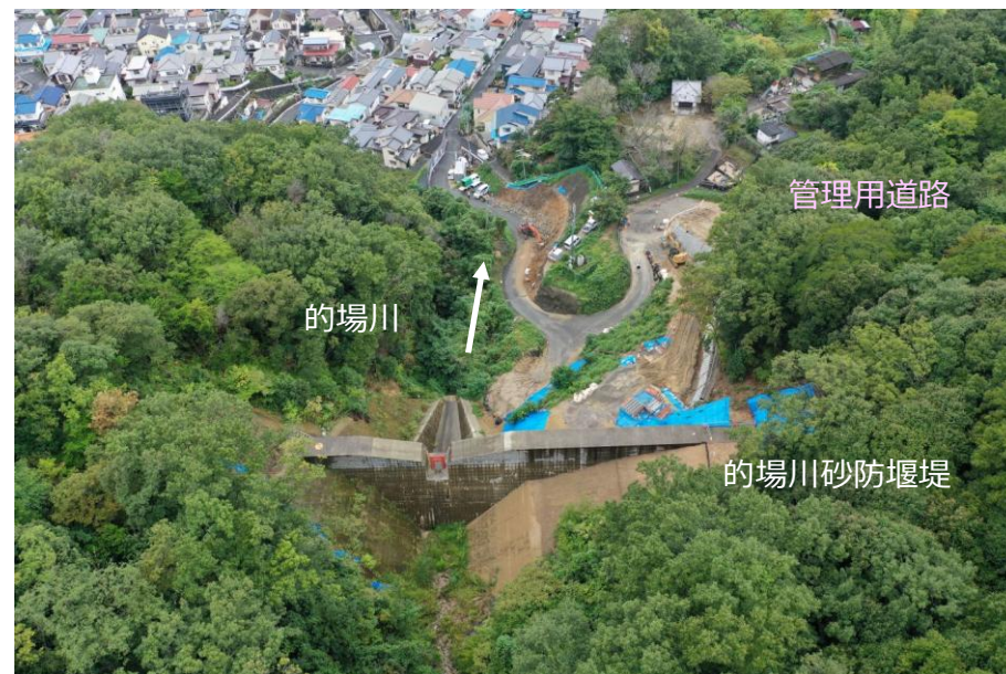
【砂防堰堤全景（上流側より）】
