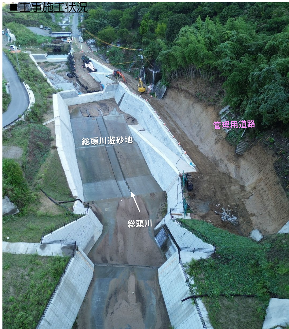
【施工状況（上流側）】
