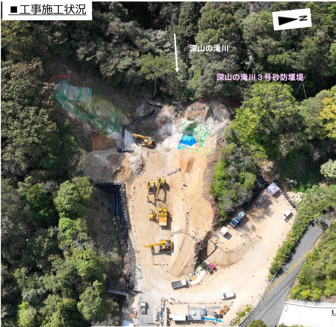
【施工状況（上空より）】
