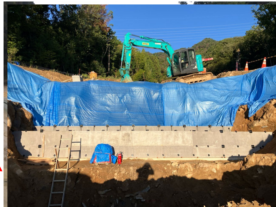
【原3号砂防堰堤下流施工状況】
