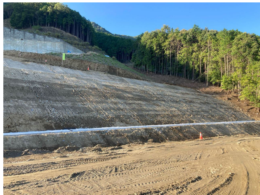
【施工状況（盛土工）】
