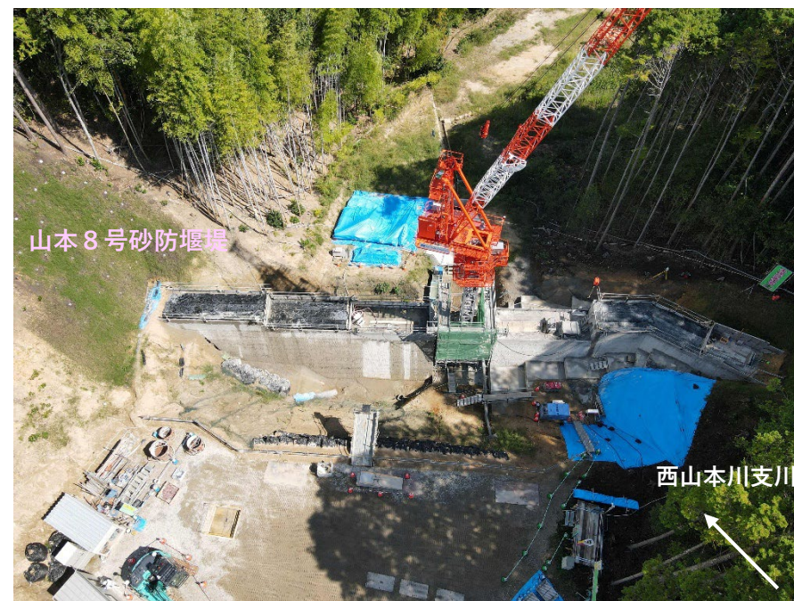
【施工状況 上流側より】
