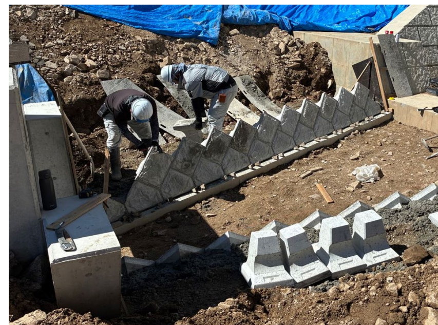
【取付流路 施工状況】
