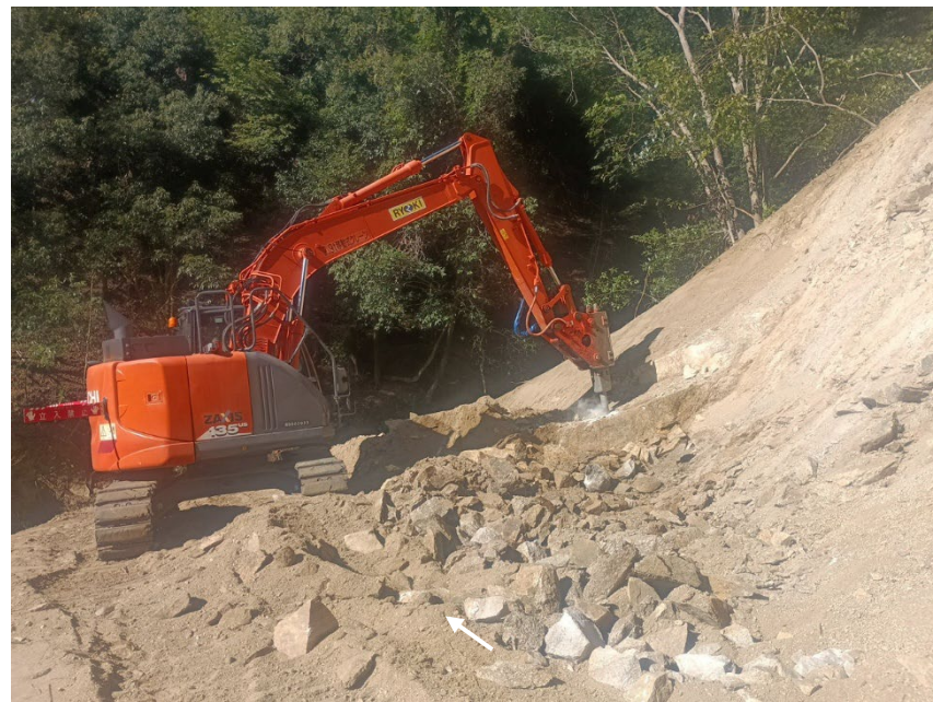
【堰堤掘削状況】
