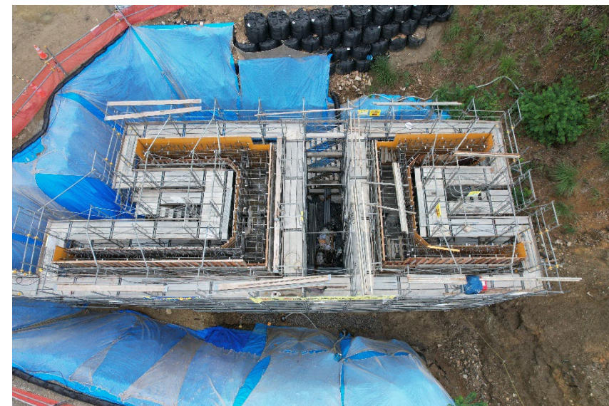
【 施工状況 橋台工】
