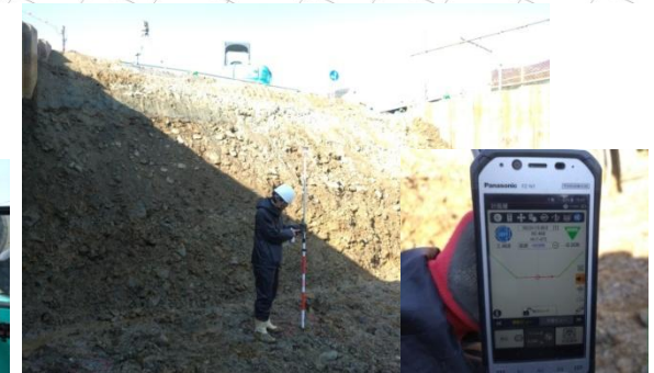
3Dデータを用いて杭ナビにより出来形確認
