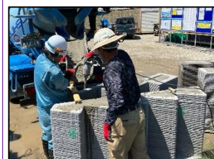
中詰コンクリート打設
