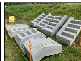
階段部材造形完了
