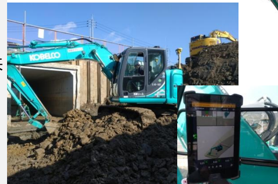
バックホウ(マシンコントロール)
