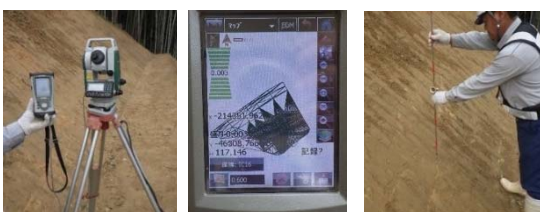
3次元設計データを搭載したTS測量
