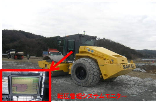
転圧管理システムによる施工状況
