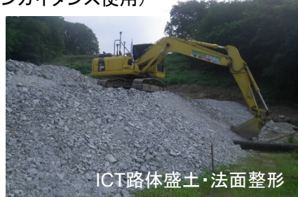
ICT建設機械施工（マシンガイダンス使用）
