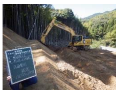
3次元MCバックホウによる施工
