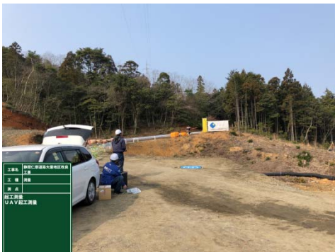
UAV測量により起工測量を実施(専門業者)
