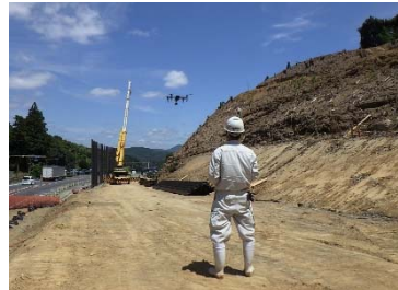
UAVとLS測量の組み合わせによる起工測量
