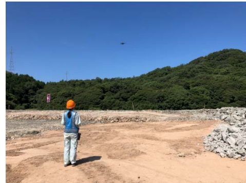
UAV測量により月々の出来形計測(自社作業)
