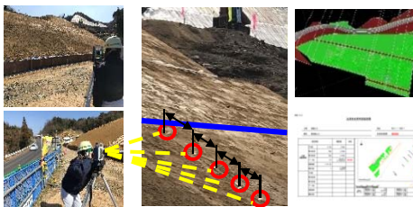
ノンプリズムTS取得座標による面的評価
