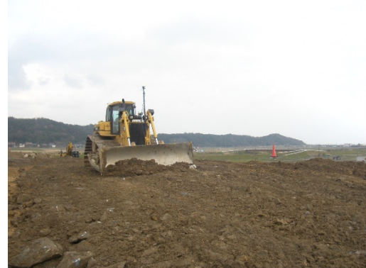
ICT建機(マシンガイダンス)による施工状況
