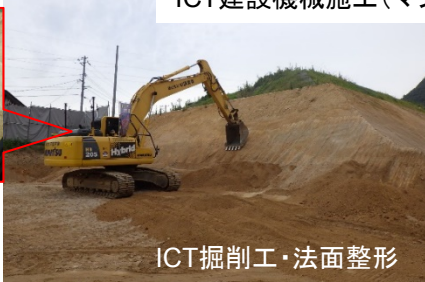
ICT建設機械施工（マシンガイダンス使用）
