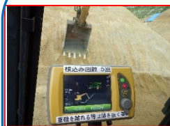
重機運転席内モニター 施工誤差表示
