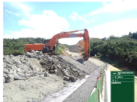
ICT建設機械施工状況
