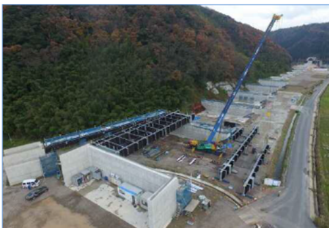
橋梁工事(青谷高架橋)
