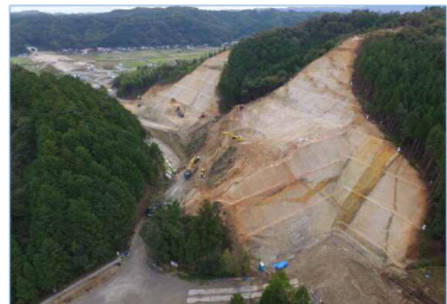
改良工事(鳥取市重山地内)
