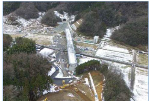
福井高架橋及び福井・御熊トンネル
