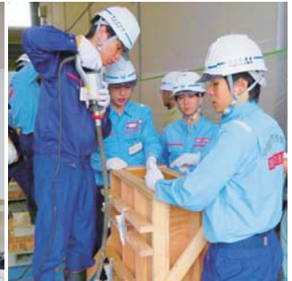
逆T擁壁の作成
