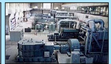
内水被害を防止するための「ゲート設備」(水門) 及び「排水機場(大型ポンプ設備)」
