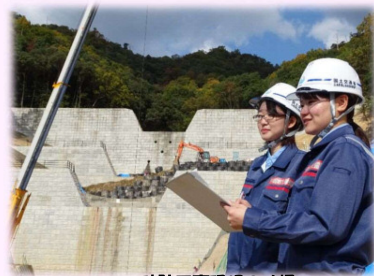
砂防工事現場の確認
