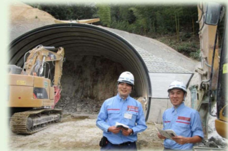
トンネル工事現場にて
