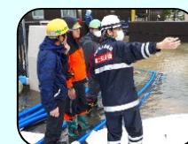
現地での排水ポンプ車 での排水活動の調整状況
