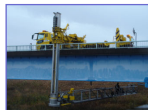
橋梁点検車(歩廊型)
