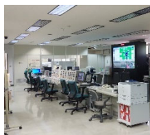
ダム管理所操作室
