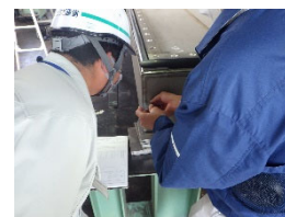
小形水門の工場製作時の 寸法検査の立会（監督業務）
