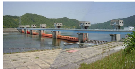
堰ゲート設備
