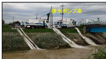
排水活動(茨城県常総市)
