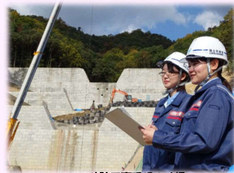
砂防工事現場の確認
