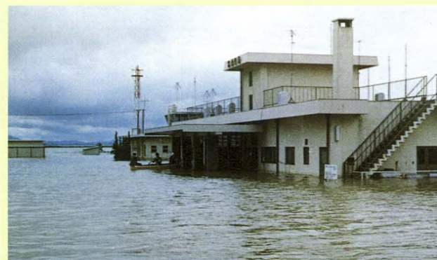
昭和47年洪水時の出雲空港の水没した様子
