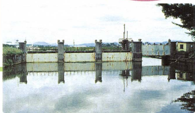
新内藤川水門
