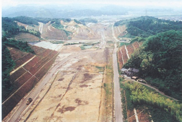
開削部掘削状況 (平成14年6月)
