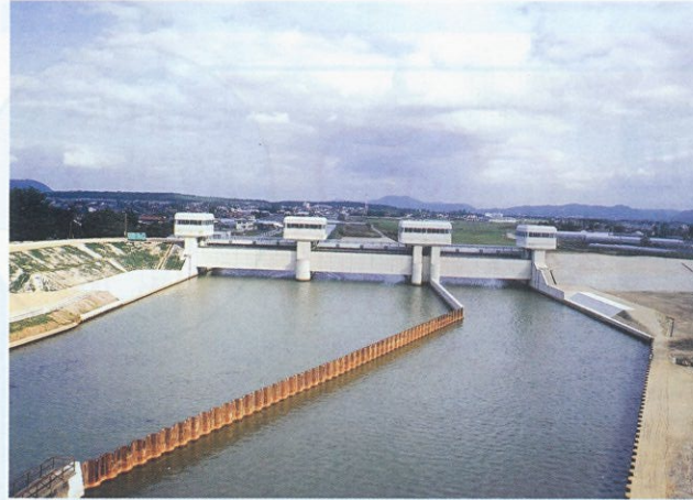
新内藤川水門完成 (平成10年11月)
