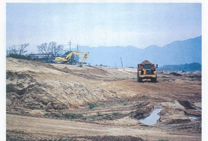
拡幅部堤防工事本格着手 (平成9年12月)
